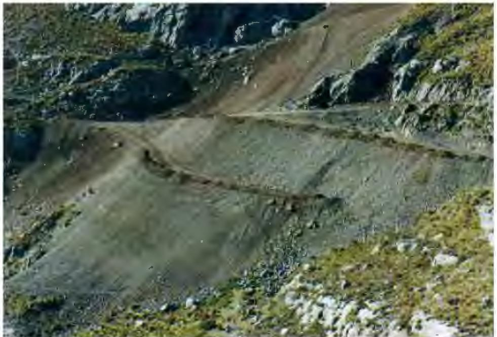
Fotografía 8: Recubrimiento con tierra vegetal de cancha de desmonte Socorro Nv. 630.
