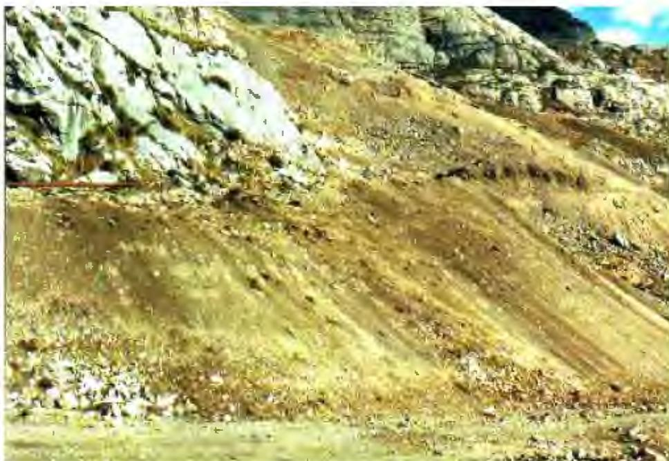
Fotografía 5: Recubrimiento con tierra vegetal de cancha de desmonte Carmen Nv. 550.
