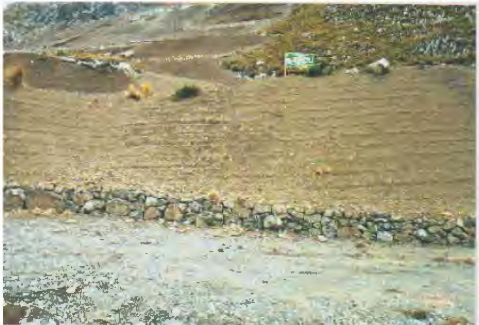
Fotografía 4: Recubrimiento con tierra vegetal de cancha de desmonte Carmen Nv. 500.
