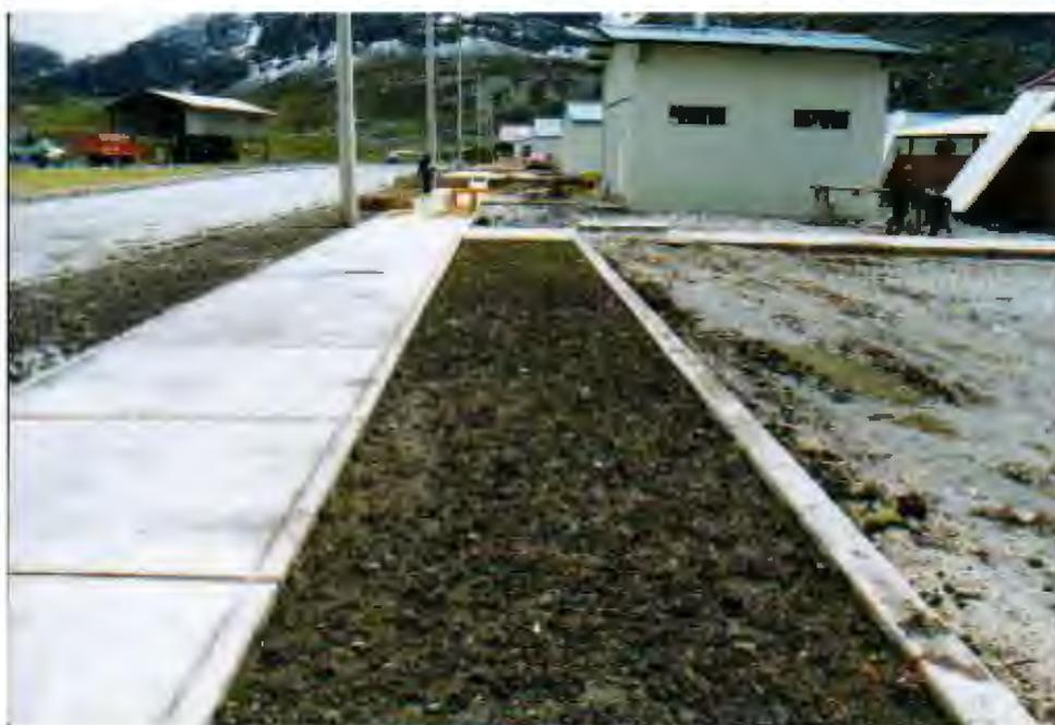
Fotografía 2: Recubrimiento con tierra vegetal de cancha de desmonte Casualidad Nv. 450.
