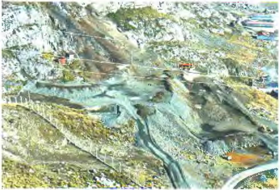
Fotografía 7: Recubrimiento con tierra vegetal de cancha de desmonte Socorro Nv. 500 - 550.
