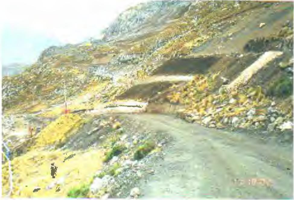
Fotografía 3: Recubrimiento con tierra vegetal de cancha de desmonte Casualidad Nv. 500.
