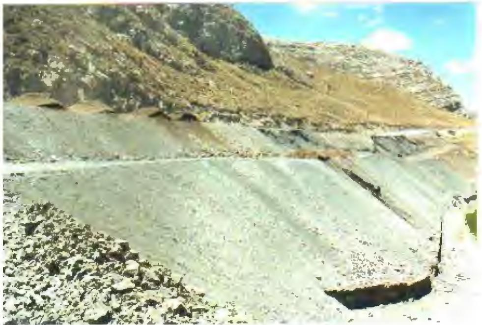
Fotografía 12: Recubrimiento con tierra vegetal en talud Colquicocha.
