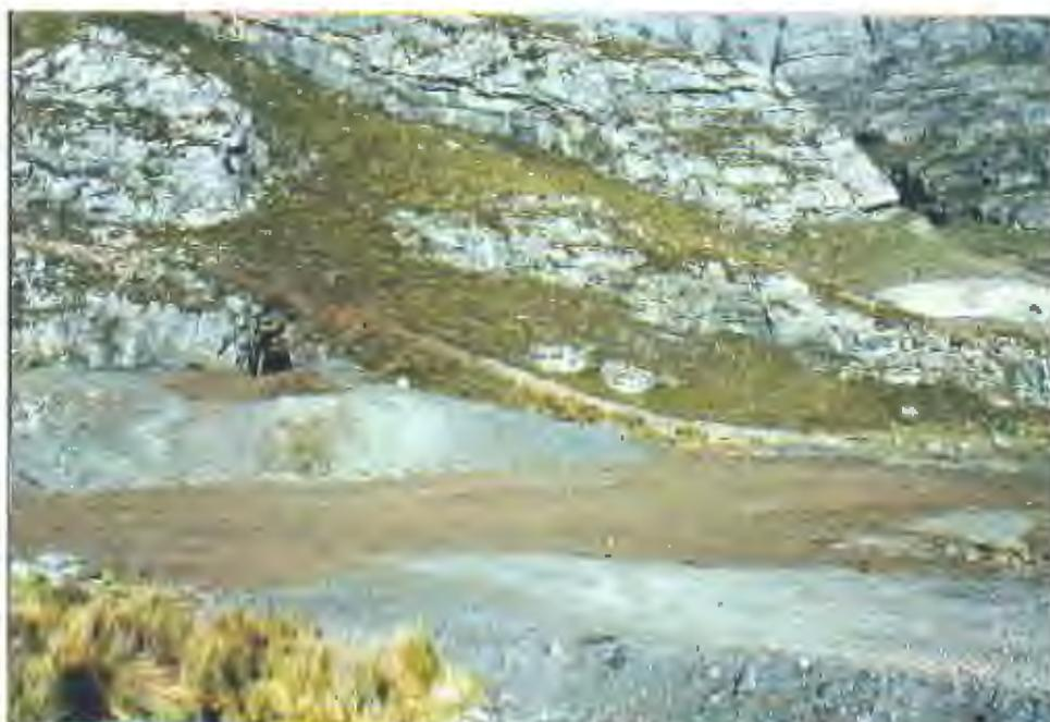
Fotografía 10: Recubrimiento con tierra vegetal de cancha de desmonte Lucrecia Nv. 550.
