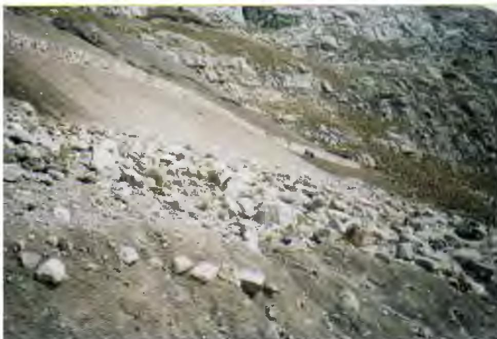
Fotografía 6: Recubrimiento con tierra vegetal de cancha de desmonte Carmen Nv. 630.
