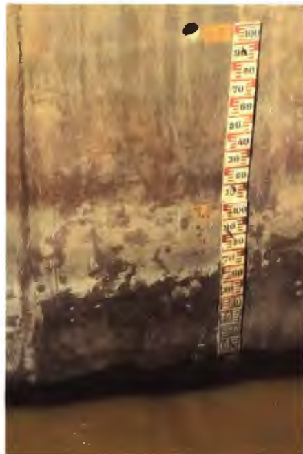
Figura N° 19: Vista de altura actual de tirante del rio.
