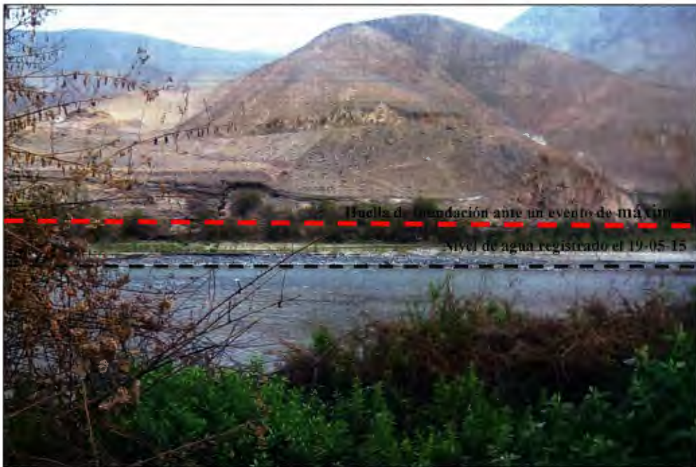
Figura 14. Identificación de la huella del nivel de agua alcanzado durante un evento de máximas avenidas
