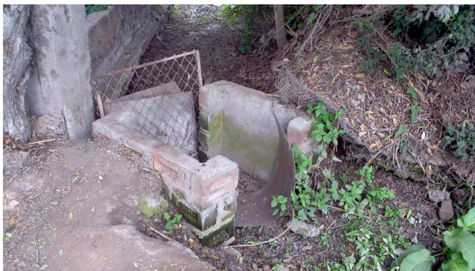
Figura N° 38: Punto de ingreso de agua al área del Programa
