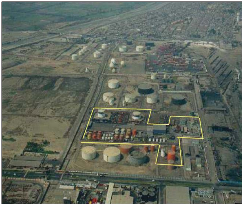
Figura 1. Ubicación de la Planta de Lubricantes Mobil
