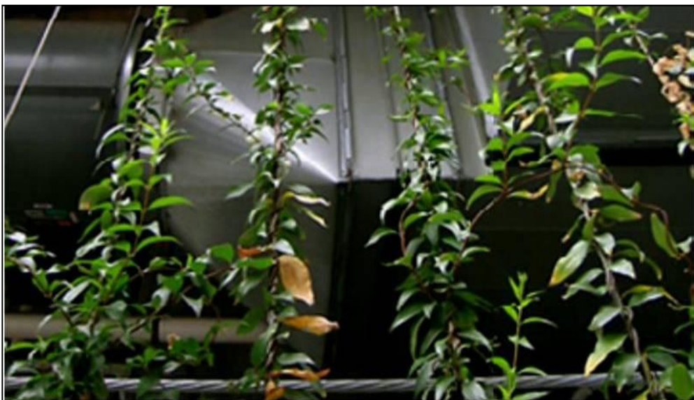
Figura 2: Sistema de Cables
