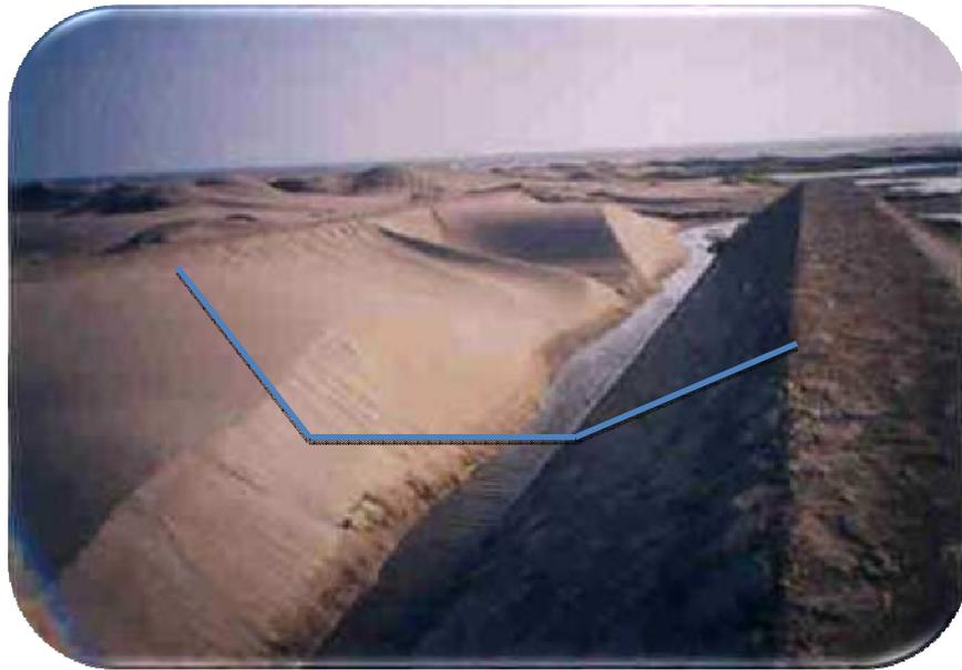
Foto N.º 20: Se observa el arenamiento de la sección hidráulica del dren D-2000 hacia el final del mismo.
