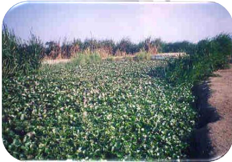
Foto N.º 08: Colmatación total de la sección hidráulica del dren D-2210 (km 0+000)
