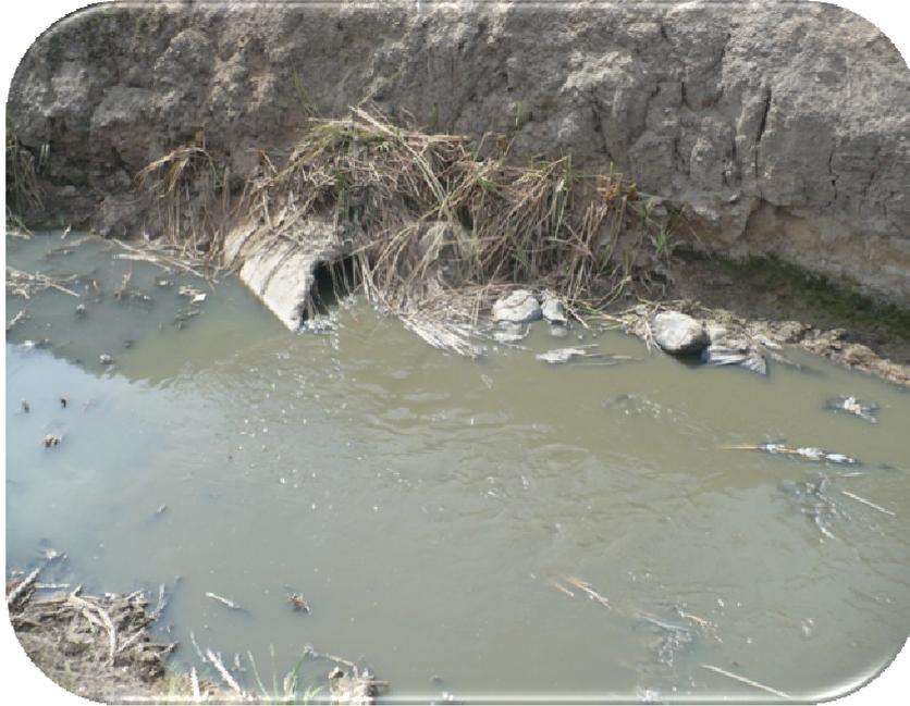
Foto N.º 12: Se observa la rotura del sistema de alcantarillado de EPSEL S.A. que proviene del distrito de la Victoria y parte de Chiclayo hacia el dren D-3100. Km 9+350
