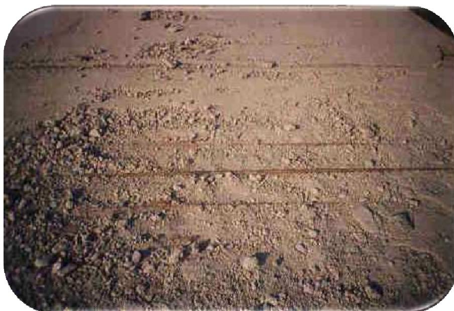
Foto N.º 22: Se observa el desgaste de la parte superior del conducto cerrado del D-2000.
