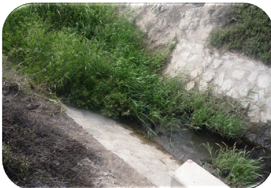
Foto N.º 07: Colmatación parcial de la sección hidráulica del dren D-1400.
