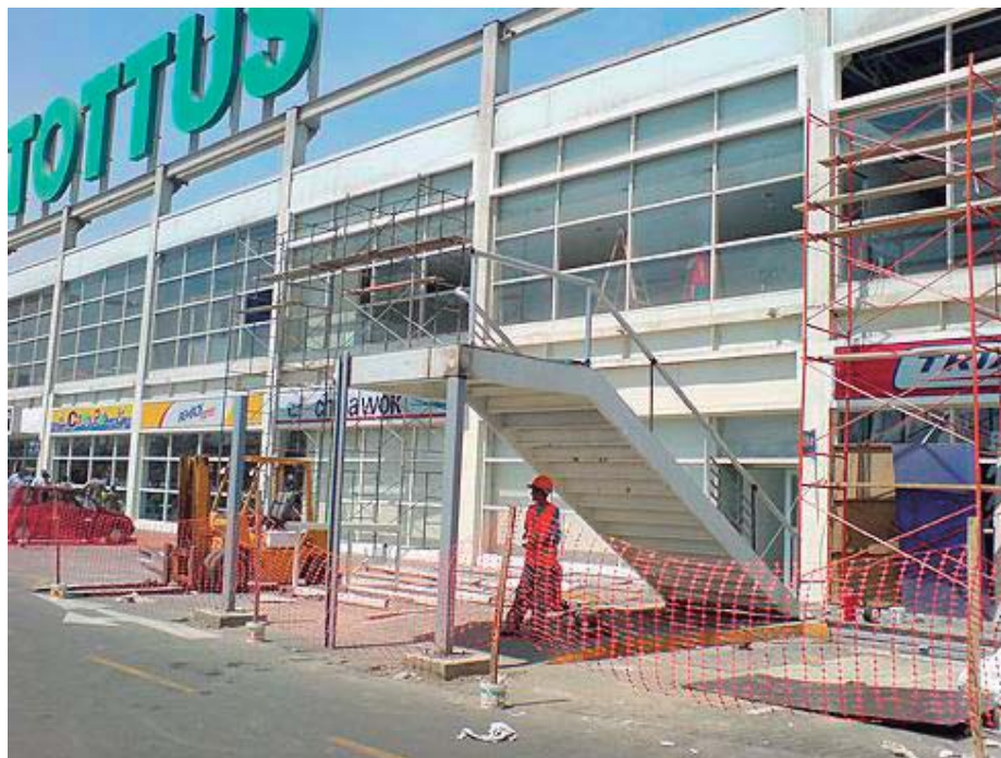
Figura 8: Obra Civil de ALL DESIGN S.A.C., en cliente TOTTUS
