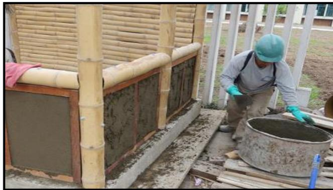
Figura 97. Revestimiento de marco de madera. (Foto: P. Chinchayán)
