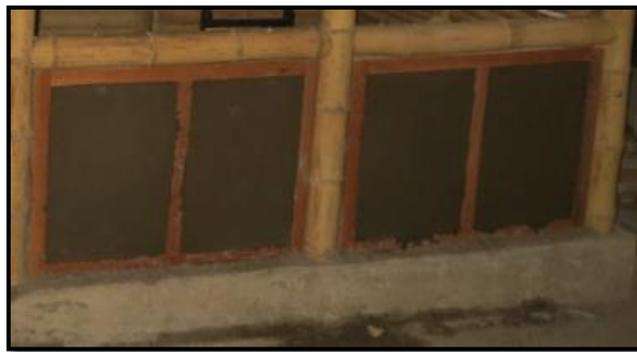
Figura 98. Cubrimiento con mortero del espesor del marco de madera.
