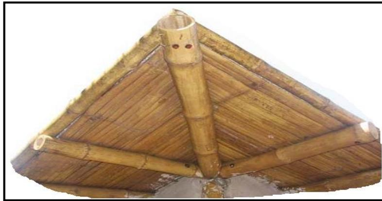
Figura 23. Techo con bambú chancado, revestido con mortero
