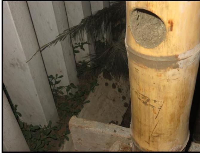
Figura 52. Mortero y concreto dentro de la columna de bambú *Guadua angustifolia*. (Foto: P. Chinchayán)
