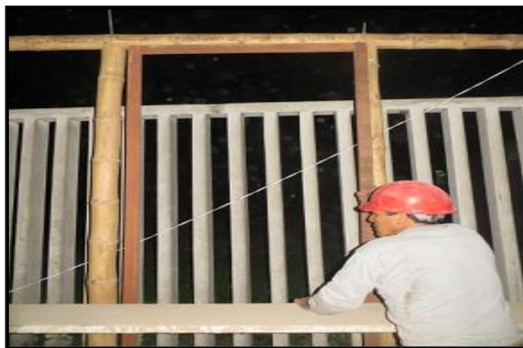
Figura 74. Marco de madera para la colocación de latillas de bambú *Guadua angustifolia*. (Foto: P. Chinchayán)
