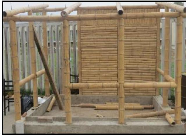
Figura 66. Bambúes con 2 bocas de pescado, unidos a las columnas
