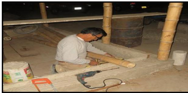
Figura 61. Ubicación y trazo de puntos a perforar para la viga simple de bambú *Guadua angustifolia*. (Foto: P. Chinchayán)
