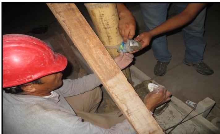
Figura 51. Vaciado de mortero y concreto especial a la columna de bambú. (Foto: P. Chinchayán)
