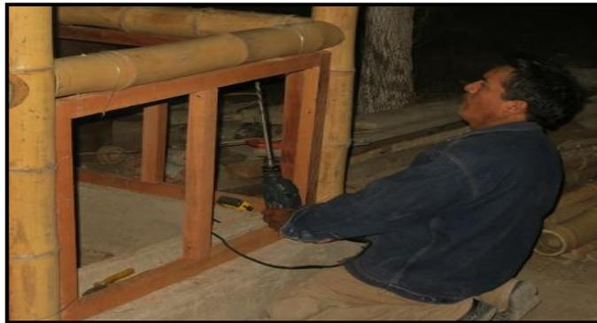
Figura 92. Perforación de marco de madera y vigueta de arriostre de bambú para la colocación de los espárragos. (Foto: P. Chinchayán)
