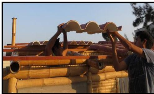
Figura 112. Colocación y fijado de teja andina fibrocemento. (Foto: P. Chinchayán)
