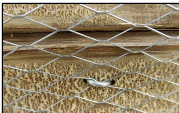
Figura 89. Fijado de malla de gallinero (0,95 m x  $\frac{3}{4}$ ”).
