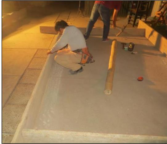
Figura: Encofrado para Sobrecimiento
