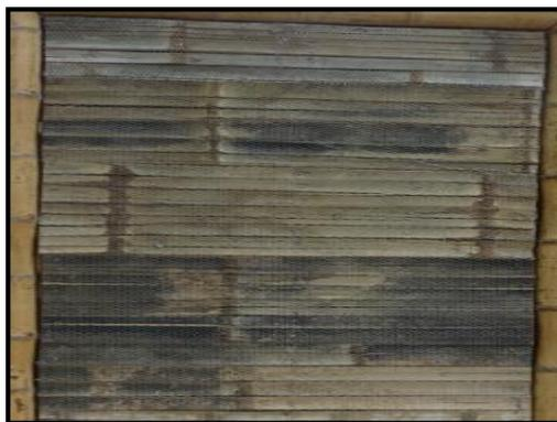
Figura 88. “Malla de gallinero” en panel de esterillas.
