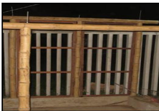
Figura 76. Marco de madera con fijación previa a la estructura de bambú. (Foto: P. Chinchayán)
