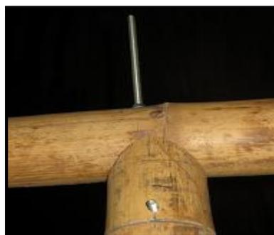
Figura 58. Espárragos colocados en la columna y viga de bambú *Guadua angustifolia*. (Foto: P.Chinchayán)
