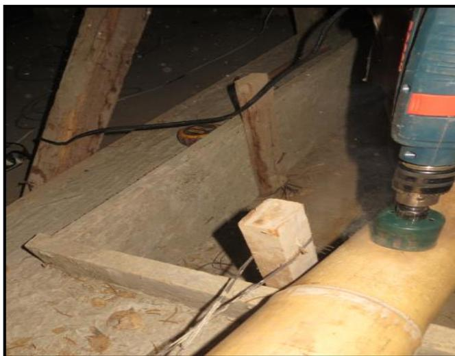
Figura 48. Perforación circular (d=2”) del bambú Guadua angustifolia, para la colocación del mortero o concreto. (Foto: P. Chinchayán)
