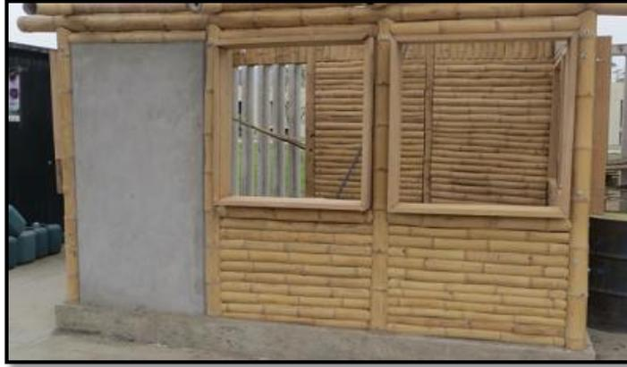
Figura71. Tarrajeo de paredes de bambú Tipo 1 y Tipo 2.
