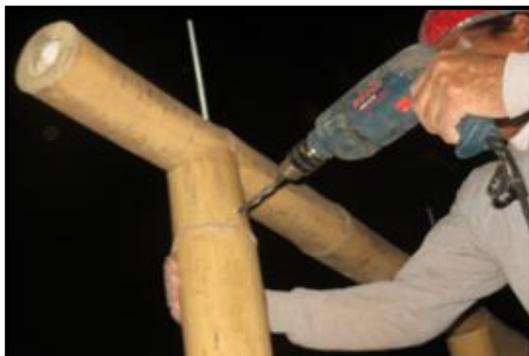
Figura 56. Perforación de viga y columna. (Foto: P. Chinchayán)
