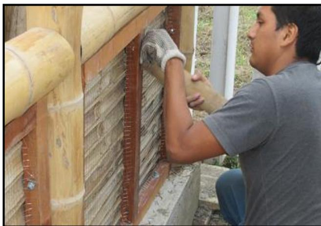
Figura 94. Fijación de malla de gallinero al marco de madera.
