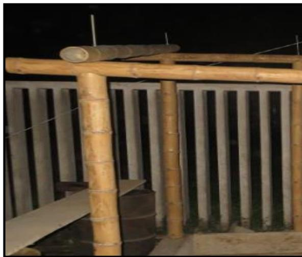
Figura 59. Viga simple colocada sobre la viga principal de bambú *Guadua angustifolia*. (Foto: P. Chinchayán)
