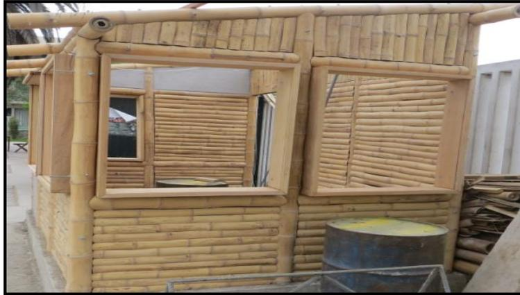
Figura 90. Panel con latillas de bambú-Tipo2. (Foto: P. Chinchayán)
