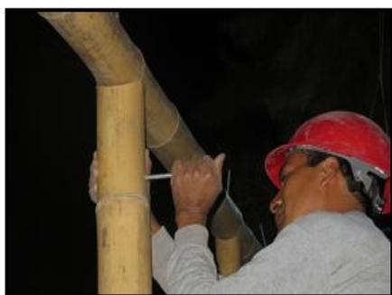
Figura 57. Colocación de espárragos (3/8”) a la Columna y viga de bambú *Guadua angustifolia*. (Foto: P.Chinchayán)
