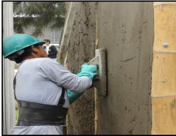
Figura 105. Tarrajeo con frotacho del panel. (Foto: P. Chinchayán)
