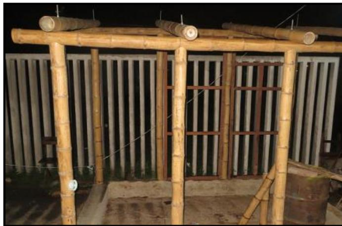
Figura 65. Vigas simples de bambú *Guadua Angustifolia* fijadas a la viga principal y columna. (Foto: P. Chinchayán)
