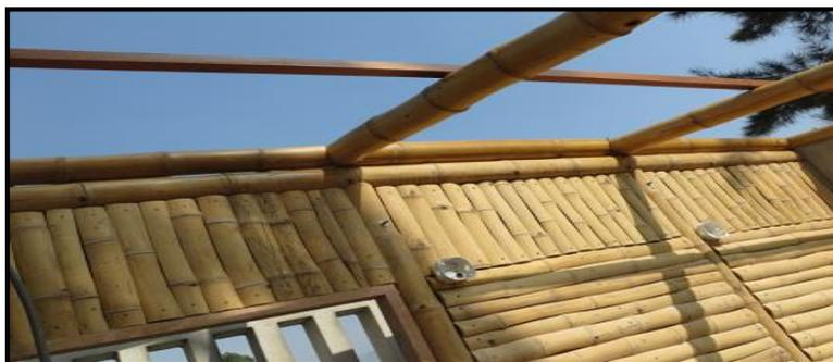
Figura 107. Listones de madera fijado a las vigas simples
