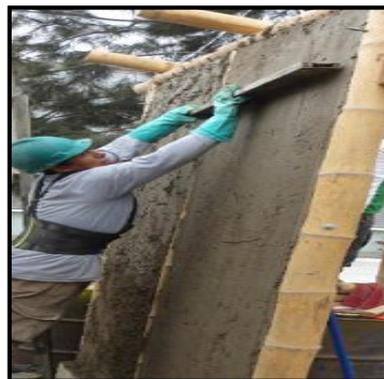
Figura 104. Nivelación con regla al mortero.
