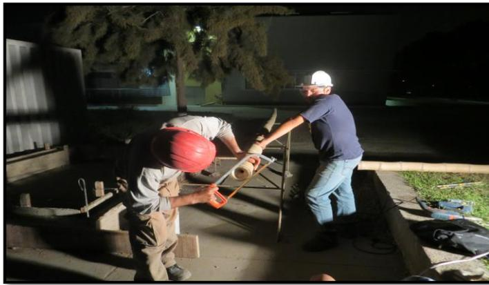
Figura 42. Corte perpendicular con sierra. (Foto: P. Chinchayán)
