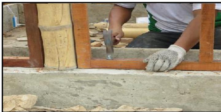
Figura 93. Fijación de espárragos al marco de madera y sobrecimiento.
