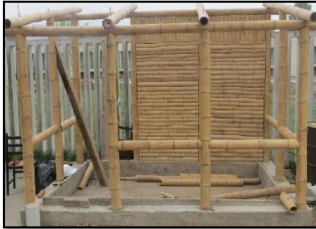
Figura 70. Vigas pequeñas colocadas entre columnas.
