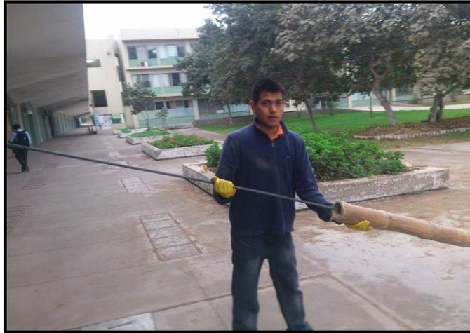
Figura 37. Perforación del bambú (diámetro de varilla: ½”)
