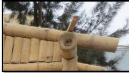
Figura 109. Listón de madera fijada a la viga simple de bambú
