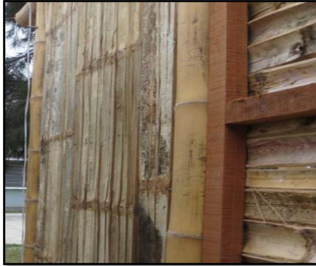
Figura 84. Bambú chancado (esterilla) y fijado al marco de madera.
