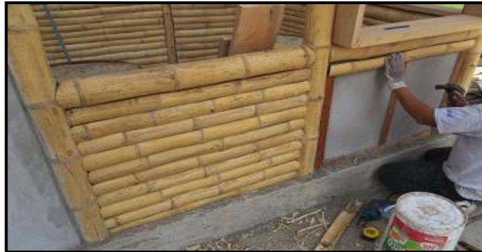
Figura 100. Colocado y fijado de latillas de bambú en la otra cara del muro.
