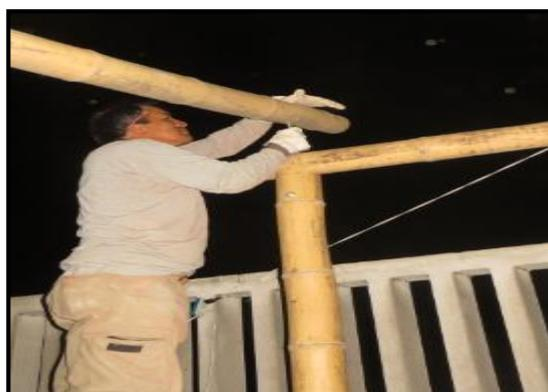
Figura 63. Colocación de viga simple a la viga principal de bambú *Guadua angustifolia*. (Foto: P. Chinchayán)
