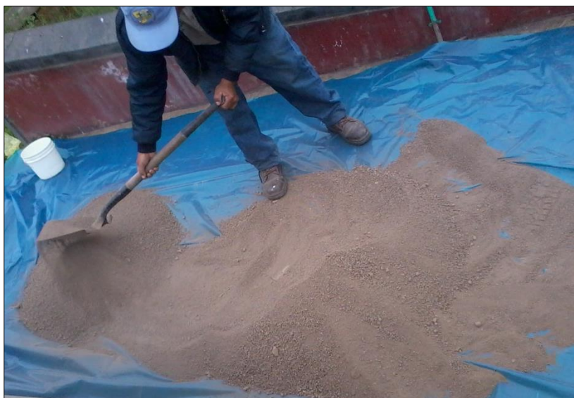
Figura N° 01: Homogenización del suelo
