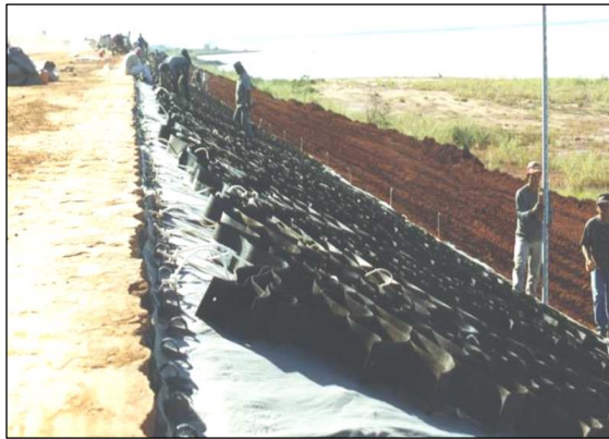
Figura 29: Instalación de geoceldas rellenas de concreto para protección de cara de presa, Mato Grosso do Sul y Rosana, São Paulo - Brasil
