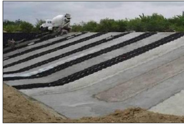
Figura 26: Instalación de geoceldas rellenas de concreto para protección de talud - Tumbes
