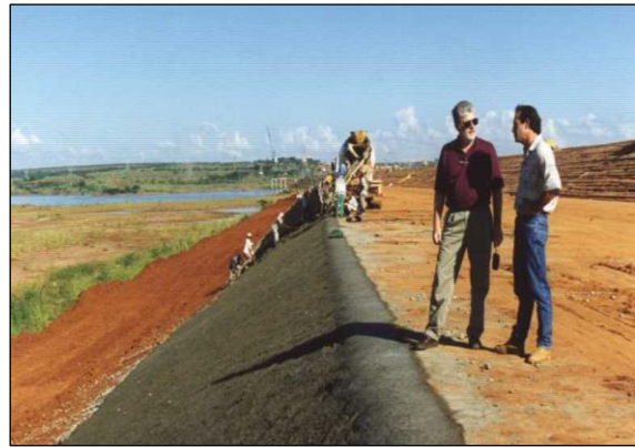
Figura 30: Instalación de geoceldas rellenas de concreto para protección de cara de presa, Mato Grosso do Sul y Rosana, São Paulo - Brasil
