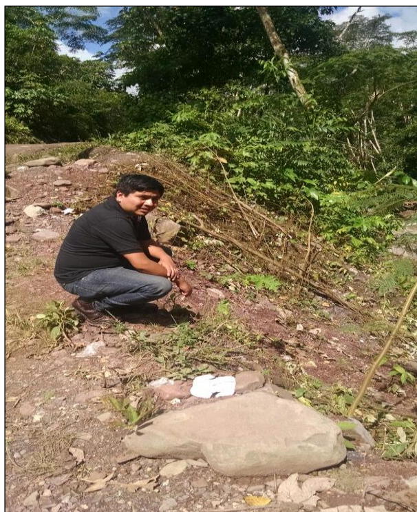
Figura 65: Imagen del talud a defender
