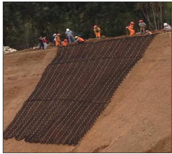
Figura 24: Instalación de geoceldas para revegetación de talud, El Blanquillo, Sartimbamba – La Libertad
