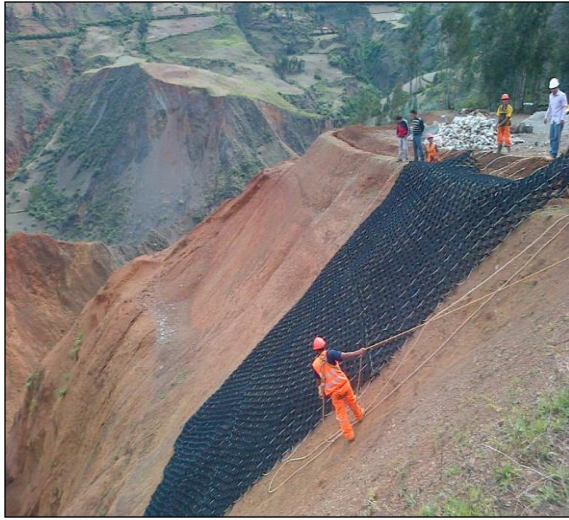
Figura 23: Instalación de geoceldas para revegetación de talud, El Blanquillo, Sartimbamba – La Libertad
