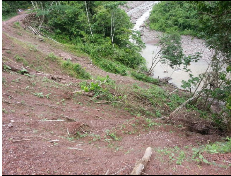
Figura 31: Fotografía del estado de la margen izquierda del río Chunchumas
