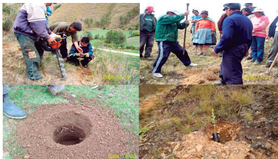
Figura 32: Apertura de hoyos con barretas y con maquina hoyadora
