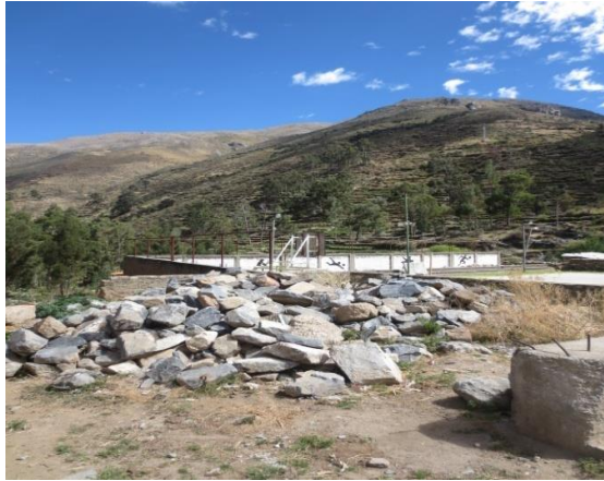
Huancaya: estructuras del colegio derrumbadas por deslizamiento del río. Julio 2013.
