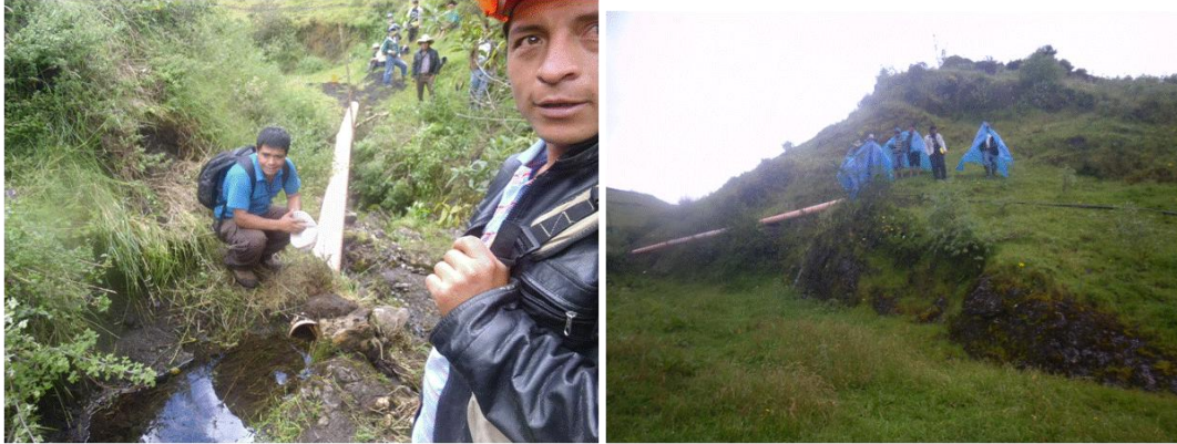
Figura N° 4.48: Traslado del agua mediante tubería y mangueras a una FC.
