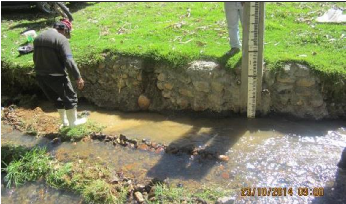
Foto 10: Limpieza del cauce del río Anya
