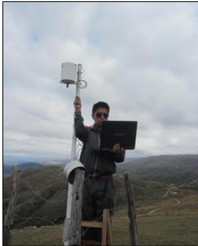
Foto 3: Procedimiento de descarga de datos, estación pluviométrica Tambo
