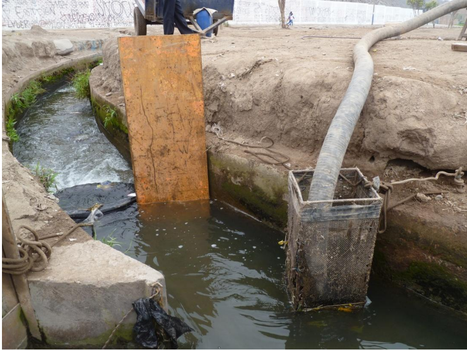
Fotografía 7.-Extracción de agua para el llenado de camión cisterna Urb. Los Portales de Javier Prado, primera etapa.
