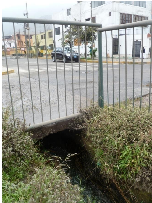
Fotografía 1.- El canal no se encuentra visible por el grado de urbanización de la zona. Cruce de la Ca. Bucaramanga y Jr. San Juan, a espaldas del colegio Alpamayo.
