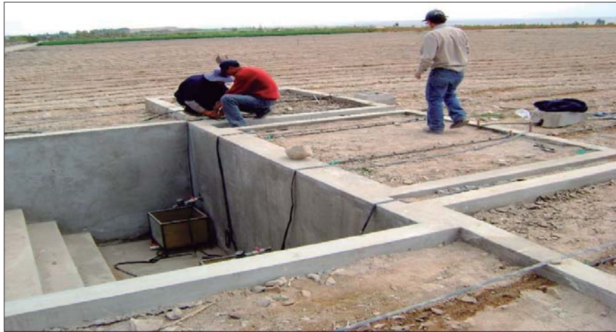
Figura 1: Reconocimiento e instalación de accesorios de riego a los lisímetros
