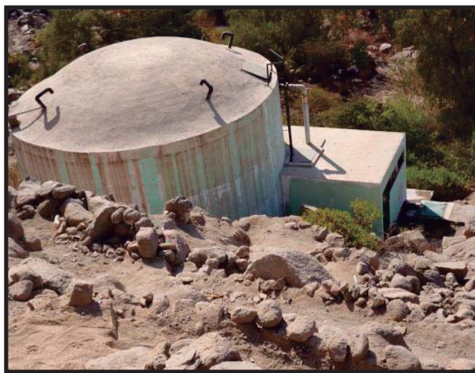
Fotografía 28: Reservorio para abastecimiento de agua potable (Distrito de Santa Eulalia)
