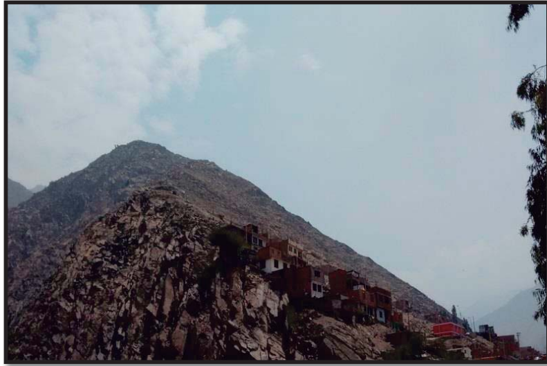
Fotografía 15: Viviendas de Santa Eulalia expuestas a peligros de deslizamiento por riesgo geológico
