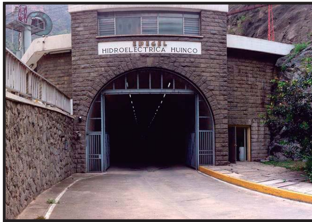
Fotografía 33: Central Hidroeléctrica Huinco
