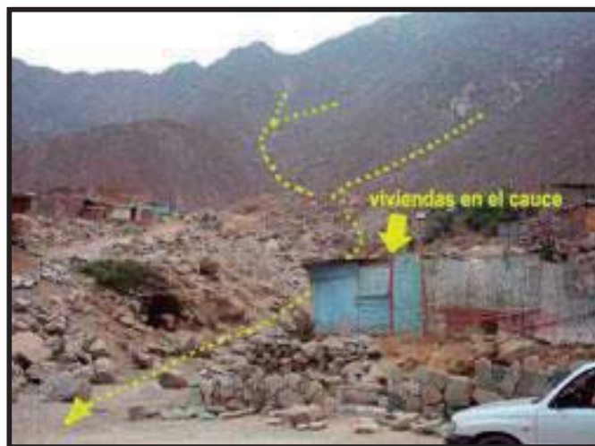
Fotografía 16: Vivienda expuesta a riesgo de desborde, inundación y huaycos de las quebradas de Huayaringa y Cashahuacra (Santa Eulalia)
