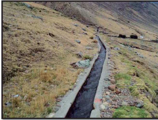
Fotografía 29: Tramo inicial del canal revestido de Acobamba (Distrito de Laraos)
