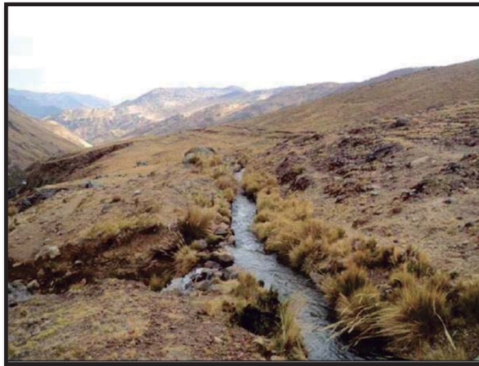
Fotografía 30: Tramo del canal sin revestir de Acobamba (Distrito de Laraos)
