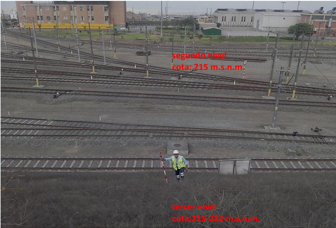
Foto N°11: Diferencia de cotas entre el segundo y tercer nivel del Patio Taller
