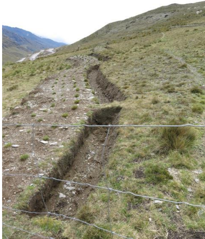
Figura 26: Zanjas de infiltración - Proyecto de Adaptación al Impacto del Retroceso Acelerado de Glaciares en los Andes Tropicales (PRAA) en la subcuenca del río Shullcas (Perú)
