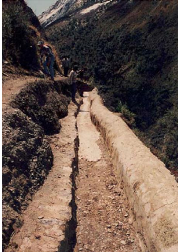
Figura 22: Vista del canal de riego Pumamarca
