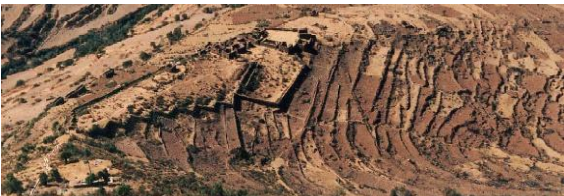
Figura 23: Vista panorámica de los andenes rehabilitados rehabilitadas a través del Proyecto Patachanga.
