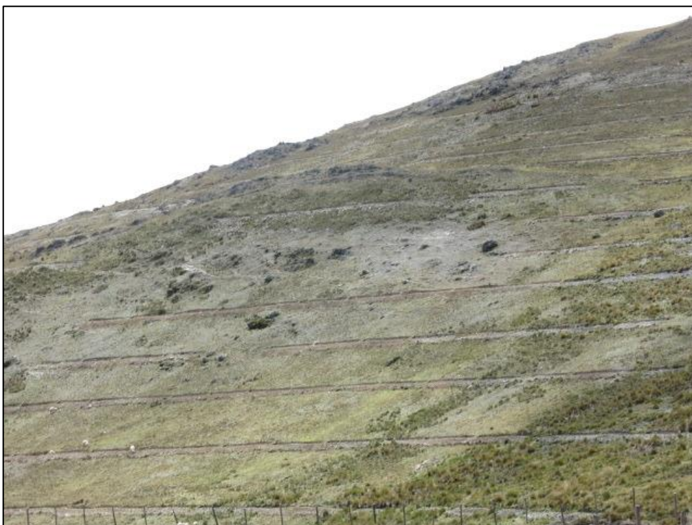
Figura A2: Zanjas de infiltración implementadas como parte del proyecto piloto de conservación de praderas altoandinas (PRAA).
