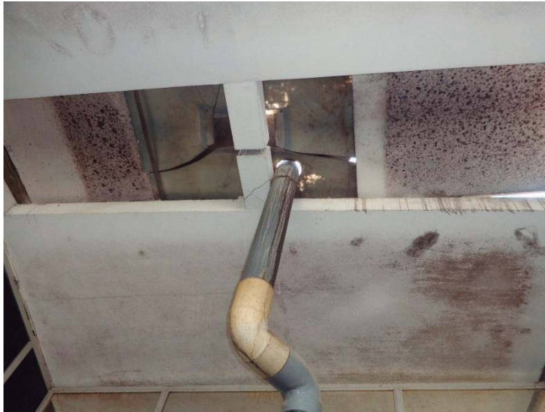
Figura 7. Techo deteriorado
