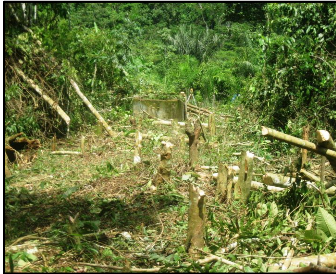
Figura N° 18: Estado Actual del Reservorio Existente.
