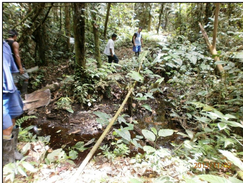
Figura N° 17: Estado Actual de la Línea de Conducción Existente.
