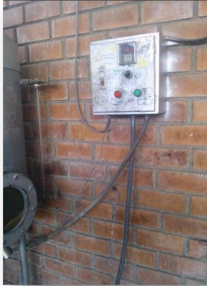
**Imagen 10: Manguera de Conexión del Purificador Deteriorada (Riesgo Alto)**
