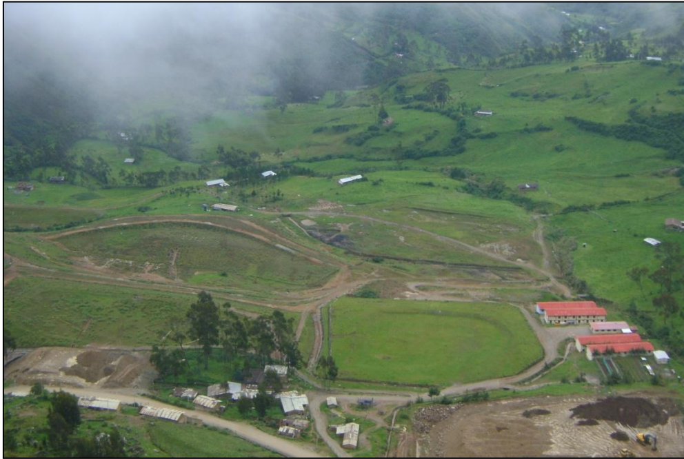
FOTOGRAFÍA 3: Vista de Viviendas del Centro Poblado Bambamarca
