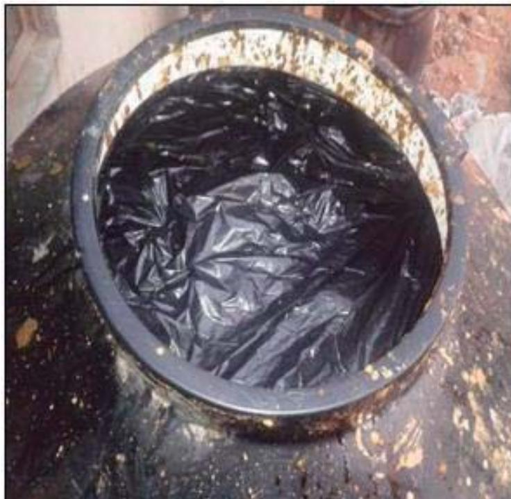
**Figura 7:** Creación de condición anaeróbica dentro del tanque.
