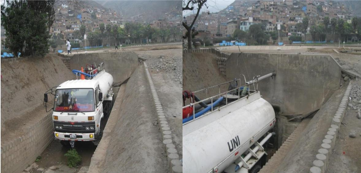
**Foto 15. Cargado por gravedad del camión cisterna con aguas residuales tratadas**
