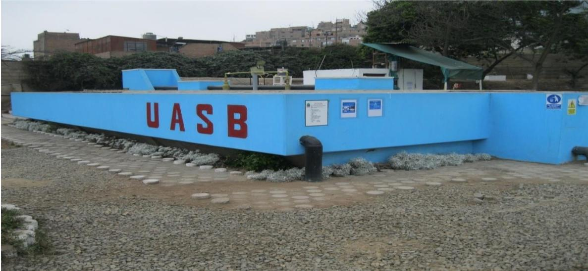
**Foto 9. Reactor Anaerobio de Manto de Lodos de Flujo Ascendente RAMLFA – UASB**
