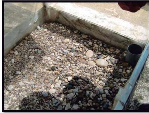
Foto 1. La cámara de subirrigación está conformada por arena, grava y gravilla
