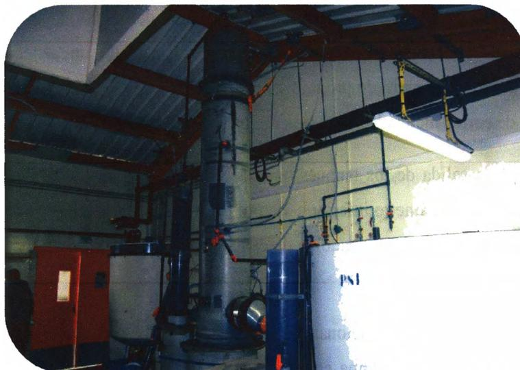
Figura 5. Columna de desgasificación a depresión COLDEP<sup>®</sup> asociada a un SRA de la estación de IFREMER de Palavas-les-Flôts (Francia); tecnología patentada por el IFREMER en 2009 [Fuente: propia].
