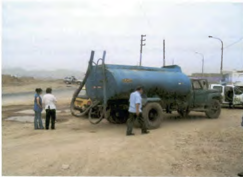
Figura 2: Regando con cisterna en Puente Piedra
