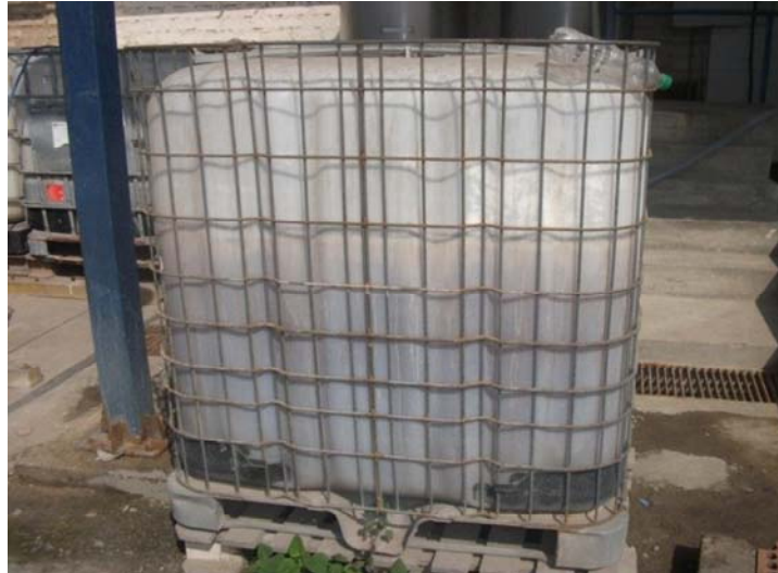
Figura 6: Tanque donde se almacena y homogeniza el efluente de descencale
