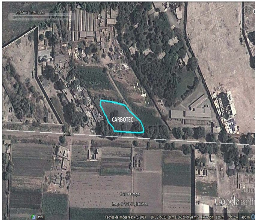
Figura 5 Ubicación y Vista del Perímetro de la empresa Evaluada (CARBOTEC S.A)
