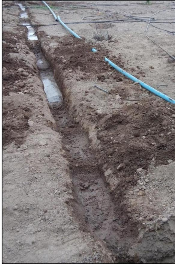
**Figura 11: Excavación de zanjas para la tubería secundaria**
