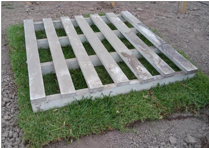
**Figura 32: Plataforma de madera para la instalación del tanque evaporímetro**
