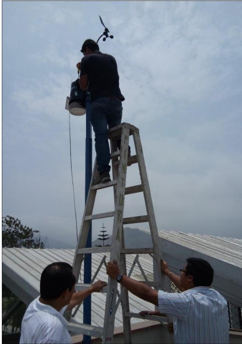
**Figura 34: Instalación de la estación meteorológica Davis**
