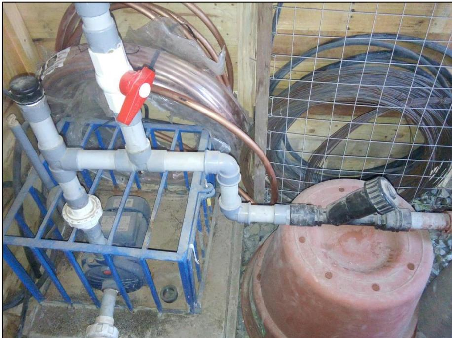
**Figura 70: Bomba hidráulica del sistema de riego**
