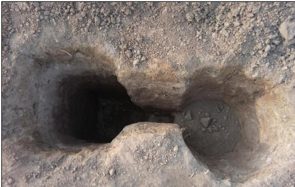
**Figura 12: Preparación del terreno para la instalación de un lisímetro**
