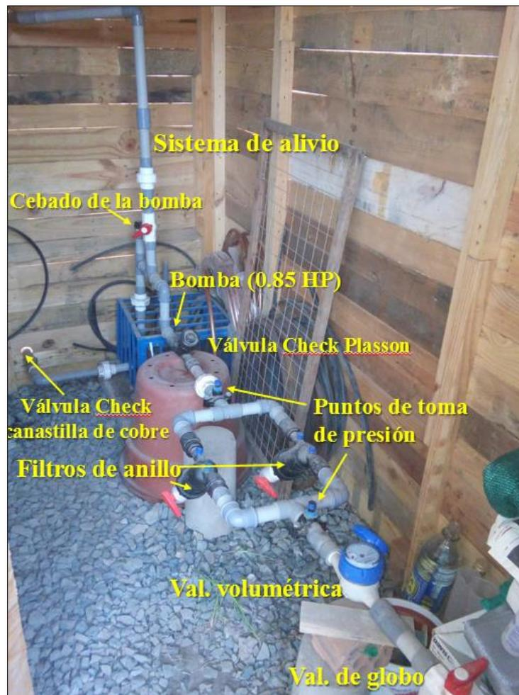
**Figura 15: Cabezal de riego y sus componentes**
