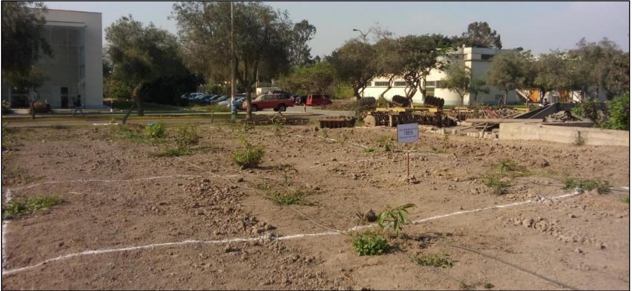
**Figura 9: Trazado con cal en las áreas de los lisímetros**
