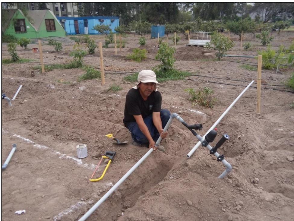
**Figura 68: Instalación de tuberías**
