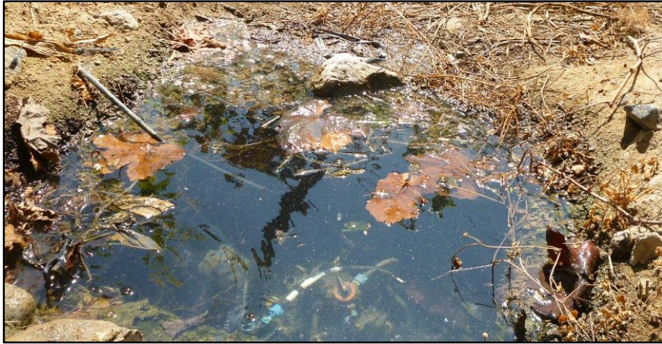
Figura 32: Estado de válvula de riego en campo.
