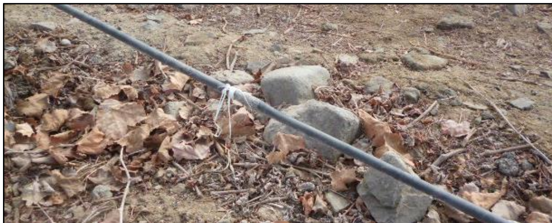
Figura 26: Emisor analizado y señalado en campo con el fin de encontrarlo fácilmente cuando se lleve a cabo la segunda evaluación del sistema. Abril, 2014.
