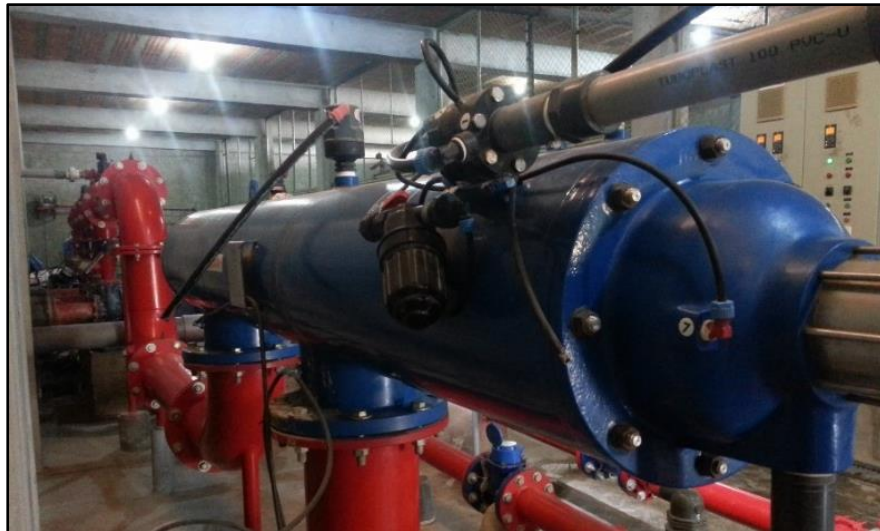
Figura 33: Filtro de malla de 8” YAMIT del campo de riego Carmin.
