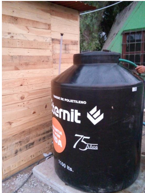
Figura 81: Colocación del tanque Eternit de 1100 L
