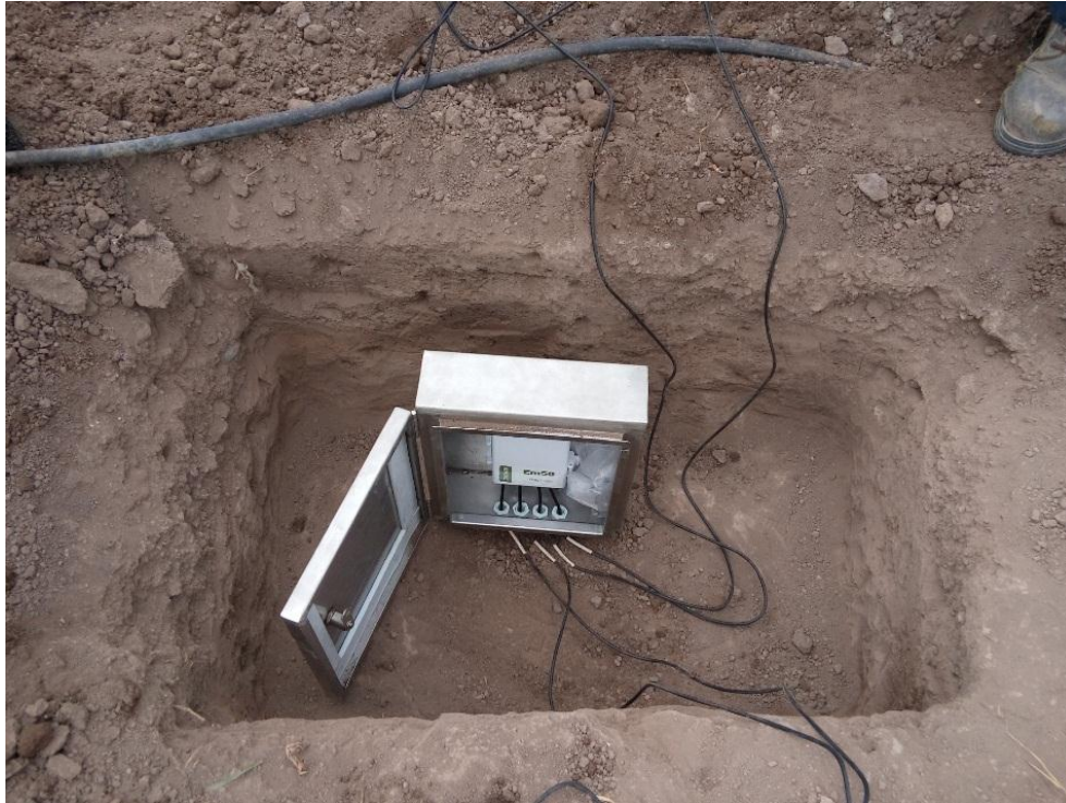
Figura 95: Instalación de caja de seguridad del Data logger
