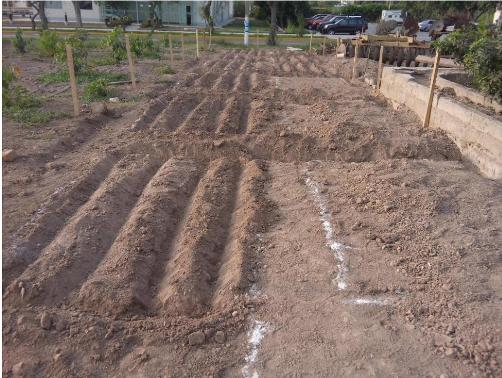
Figura 75: Excavación de zanjas por parcelas para las mangueras subterráneas
