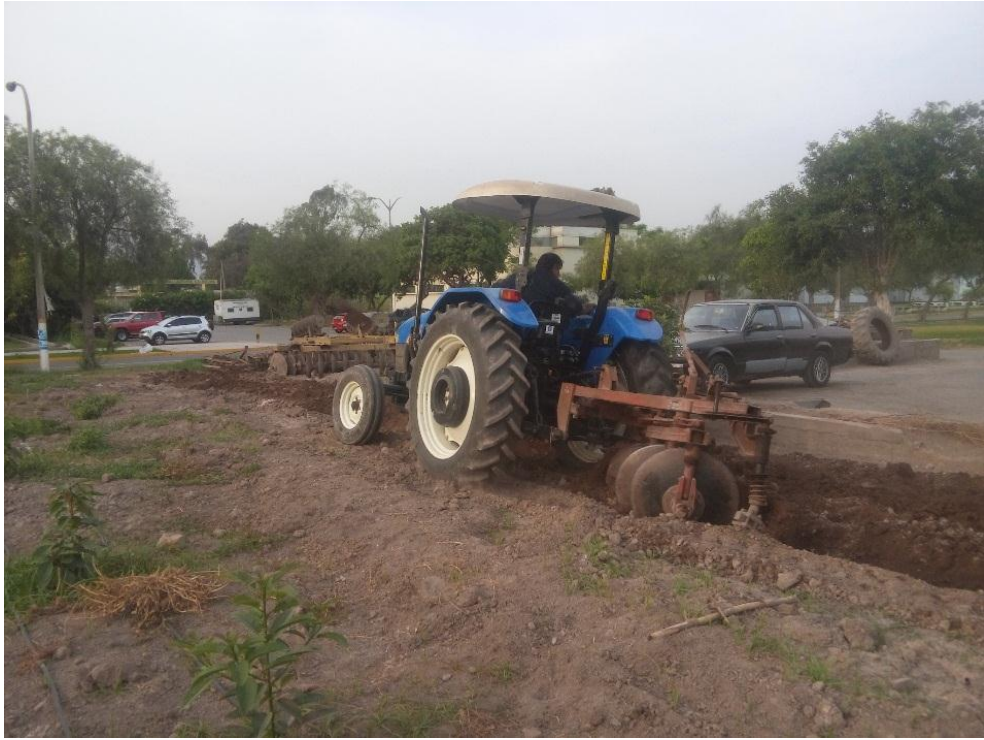
Figura 71: Preparación del terreno con maquinaria pesada
