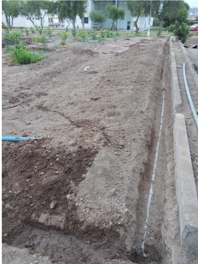
Figura 73: Excavación de zanjas e instalación de tubería principal
