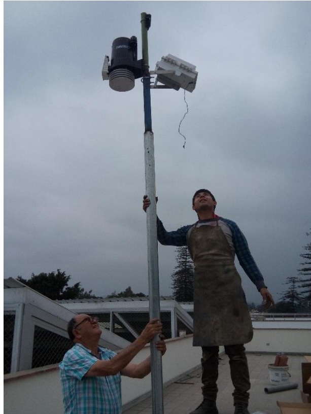
Figura 101: Poste soldado de soporte para la estación
