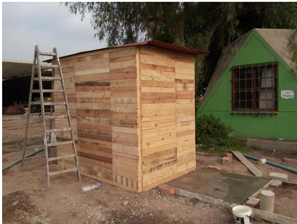
Figura 80: Construcción de la losa para el tanque y de la caseta de riego
