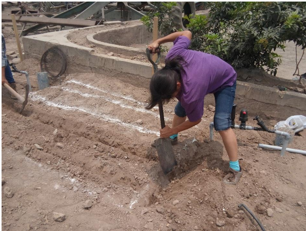
Figura 74: Excavación de zanjas para las mangueras subterráneas
