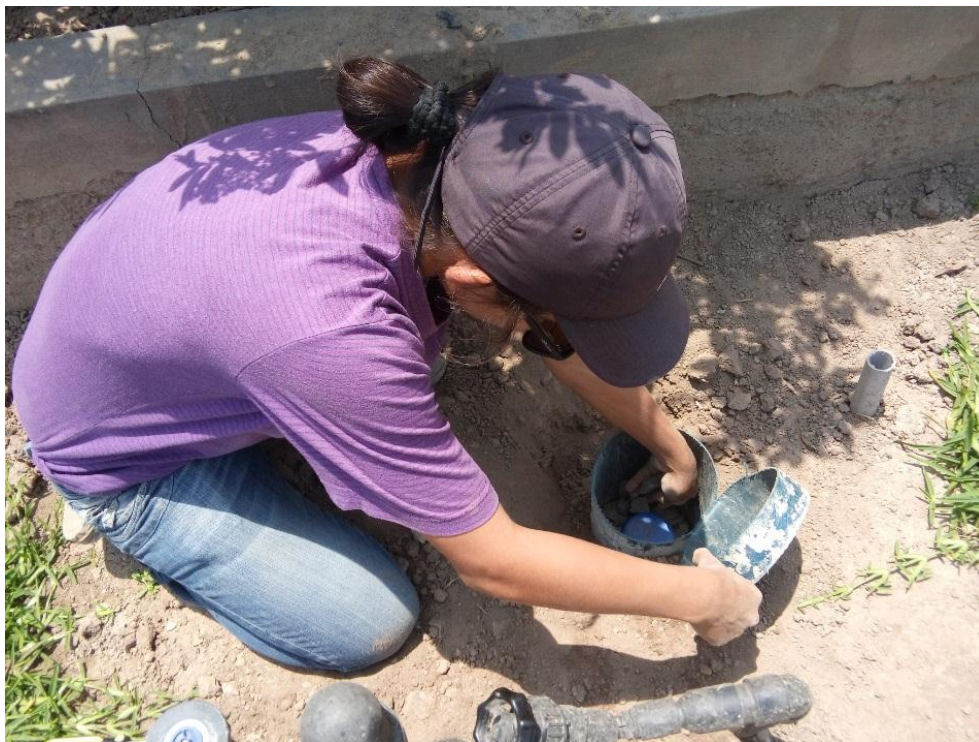
Figura 114: Control de válvulas volumétricas
