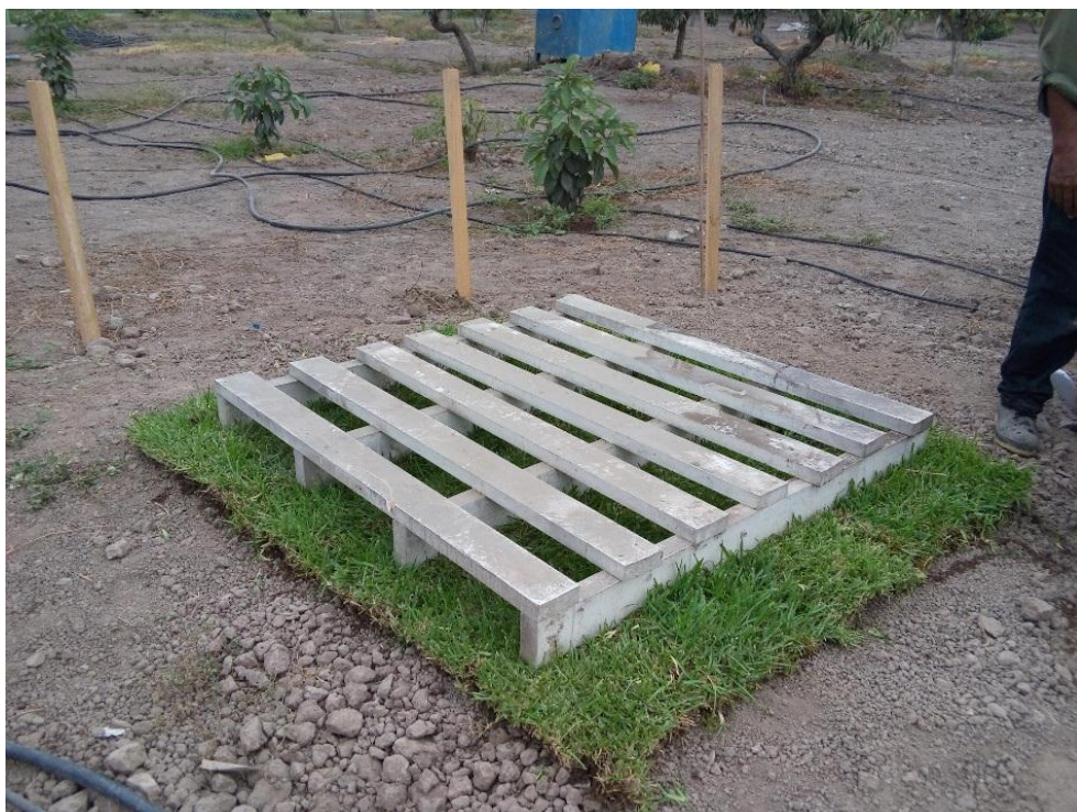
Figura 90: Instalación del apoyo del tanque evaporímetro Clase A
