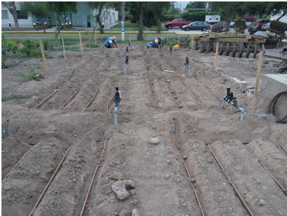
Figura 78: Mangueras de riego por goteo subterráneo instaladas
