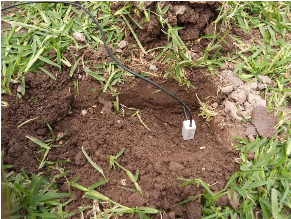
Figura 98: Instalación de los sensores de humedad
