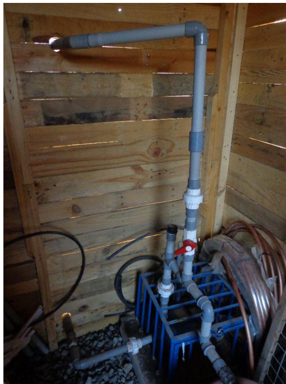
Figura 86: Sistema de alivio de presión
