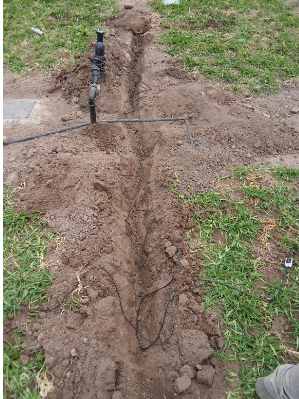
Figura 99: Zanjas para los cables de los sensores
