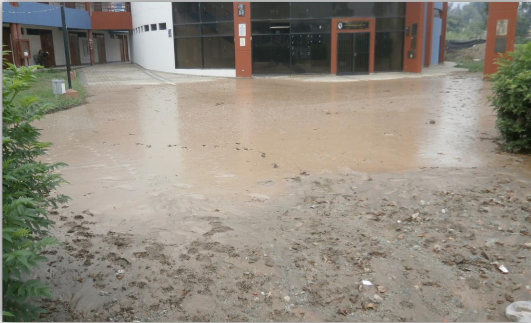
Foto N° 9: Inundación de la Facultad de Educación Física debido al huayco.
