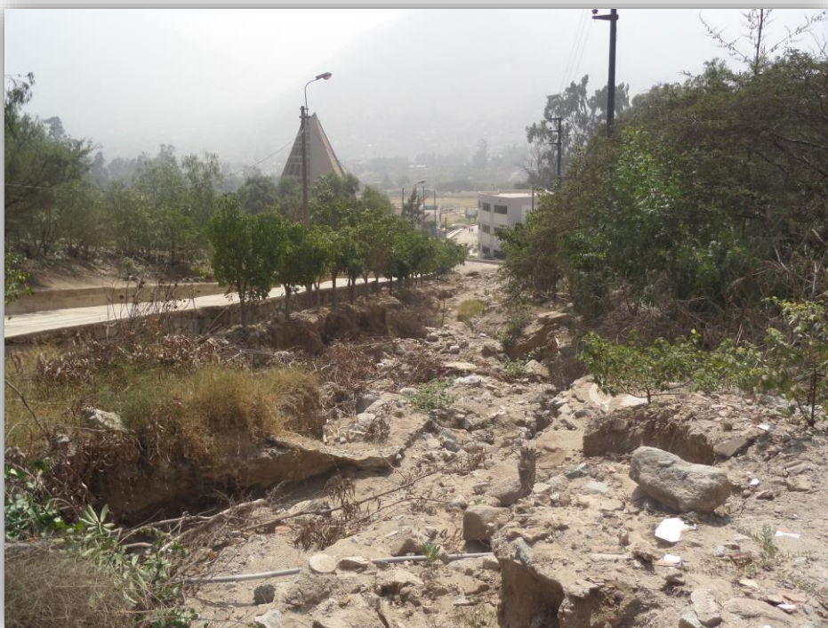
Foto N° 6: Entrada al cono de deyección (Instalaciones de la UNE)
