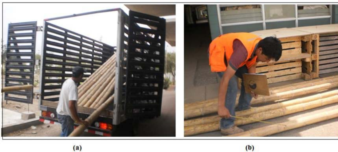
Figura 22: Recepción y marcación del bambú
