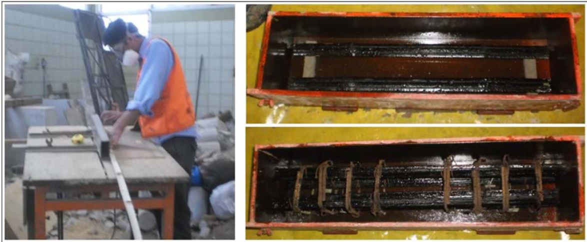
Figura 55: Habilitado del refuerzo y encofrado de las vigas
