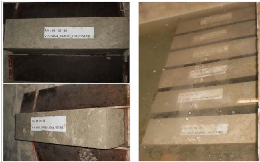
Figura 60: Desencofrado y curado de las vigas
