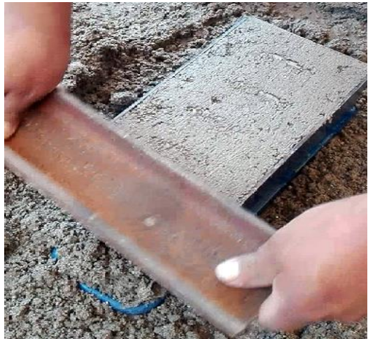
Proceso de Nivelado
