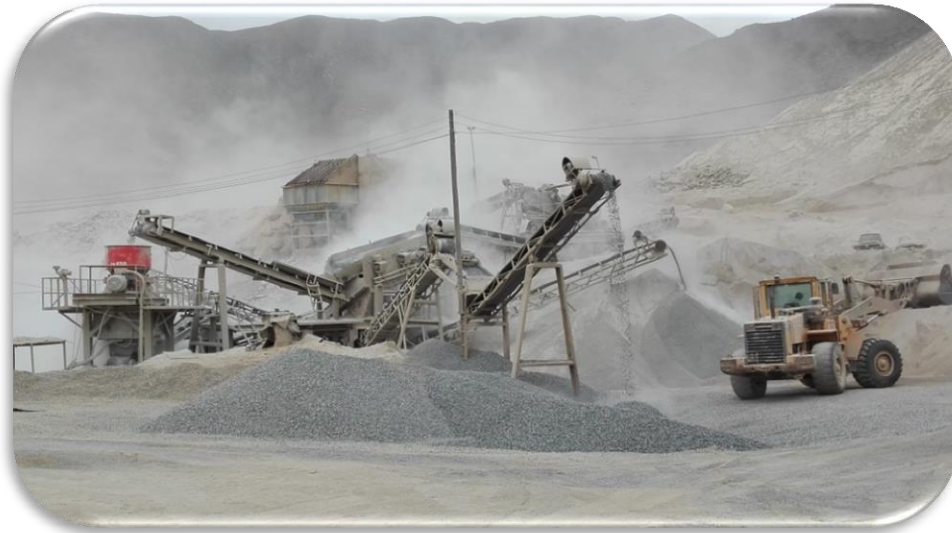
Figura 4: Traslado del agregado grueso
