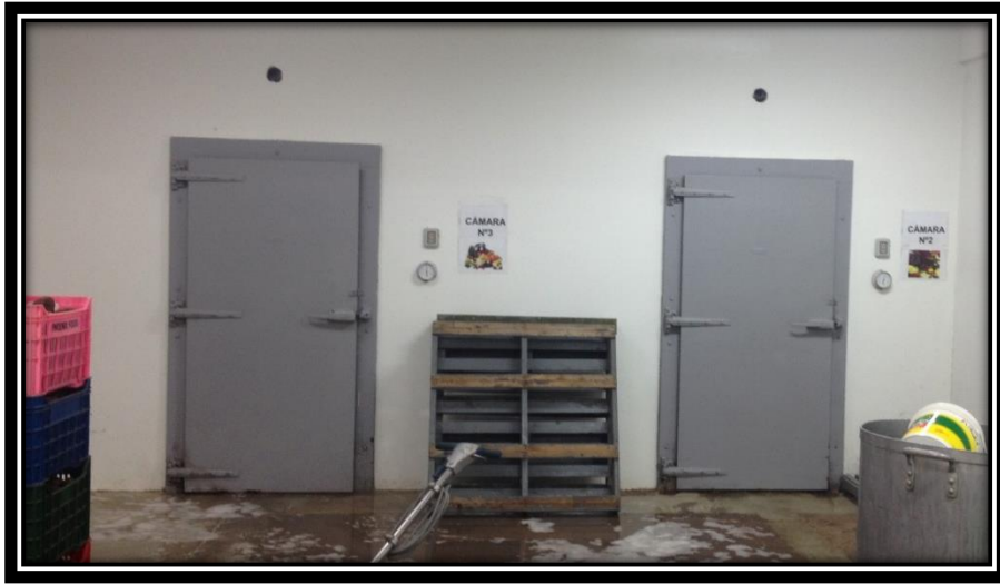
Figura 16: Cámaras de almacenamiento de alimentos del comedor universitario
