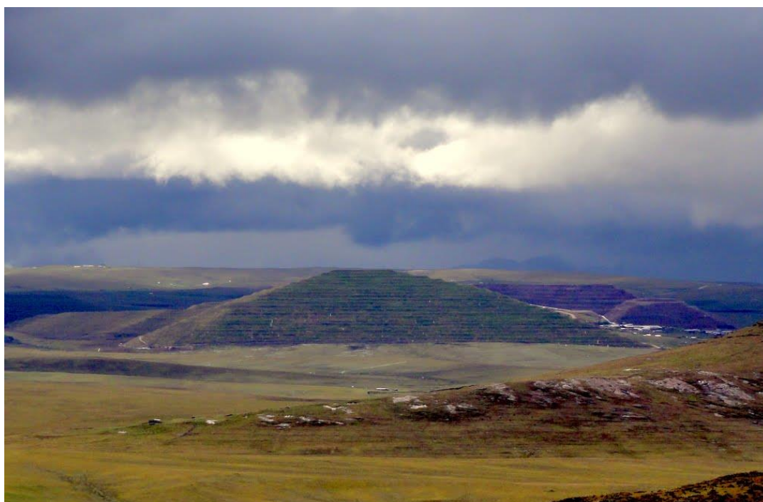
Figura 13: Vista depósitos de desmontes Suroeste
