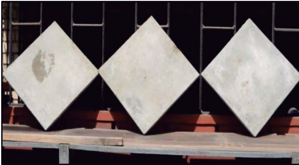
Figura 15: Disposición de los tableros para el secado
