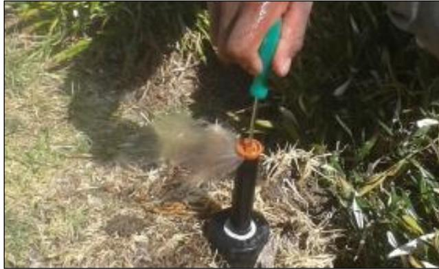
**Foto 12: Regulación del Difusor: Rango de Riego. Elaboración propia.**
