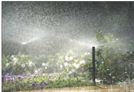
**Figura 17. Difusor emergente con boquilla de arco variable.**
