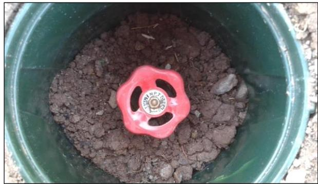
**Foto 5 y 6: Instalación de Collarín y Válvula de Control. Elaboración propia.**
