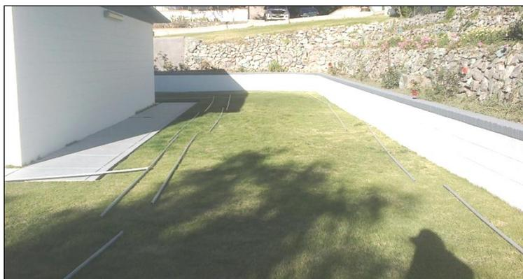
**Foto 3: Tendido de Tuberías portaemisores. Elaboración propia.**
