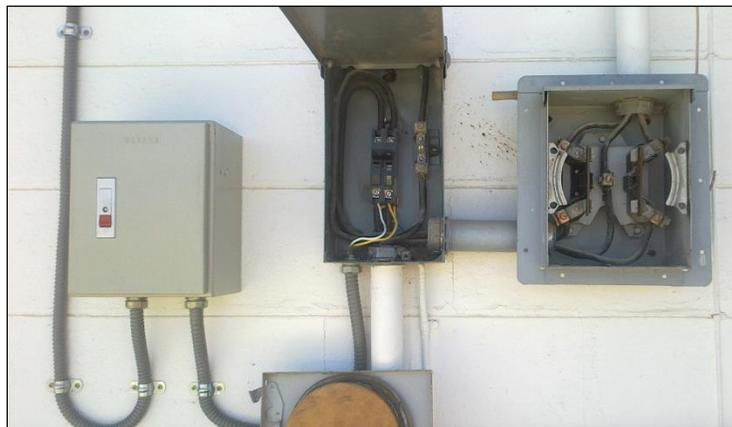
**Foto 14: Controlador de Riego en caja hermética y conexiones. Elaboración propia.**
