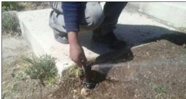
**Foto 13: Regulación del Rotor: Rango de Riego. Elaboración propia.**
