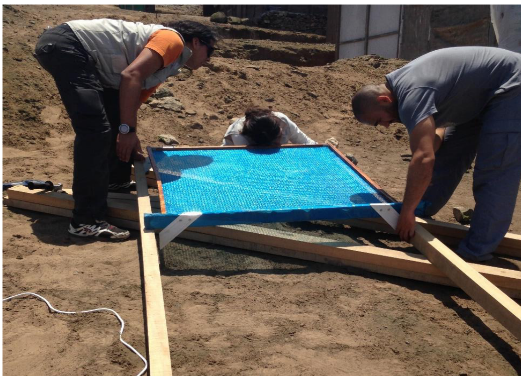
Figura 29: Unión de marco del neblinómetro SFC con parantes de madera de cuatro metros de longitud.
