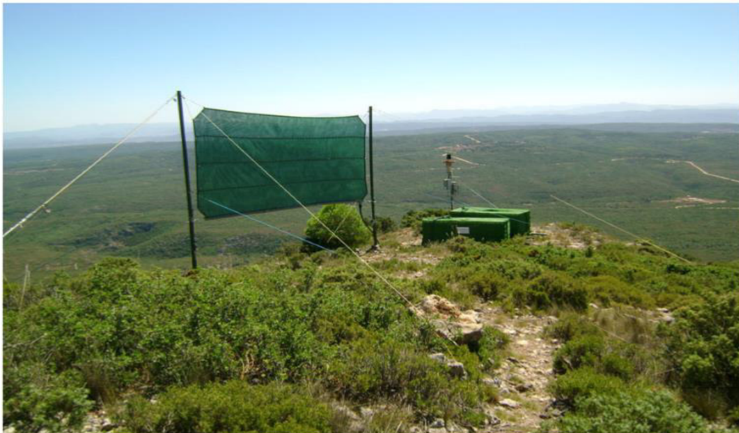
Figura 8: Captador de niebla tipo LFC instalado en Monte Machos, España.
