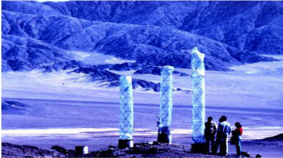
Figura 6: Captador de niebla tipo macrodiamante
