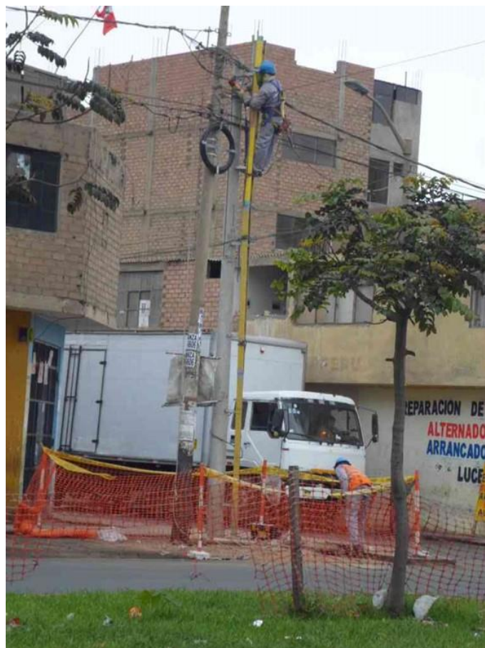
Figura N° 14: Trabajo de manejo de conexiones – actividad reparación acometida aérea
