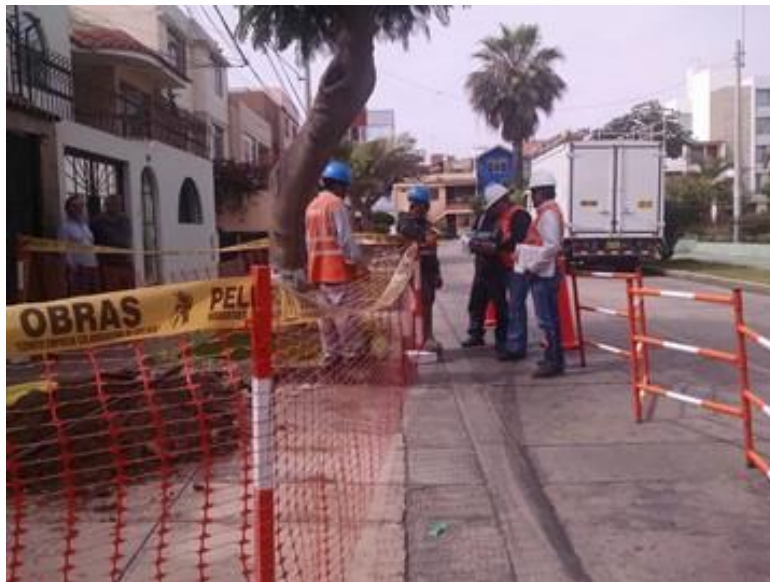
Cuadrilla del servicio de emergencia de media tensión
