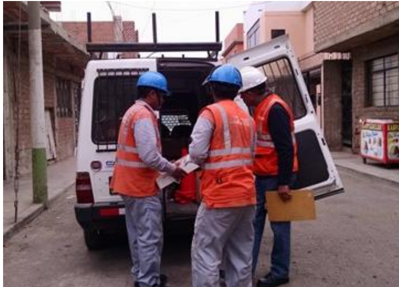
Cuadrilla del servicio de manejo de conexiones
