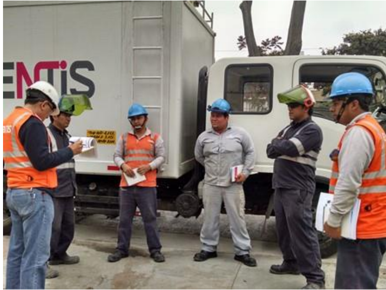
Cuadrilla del servicio de emergencia de baja tensión
