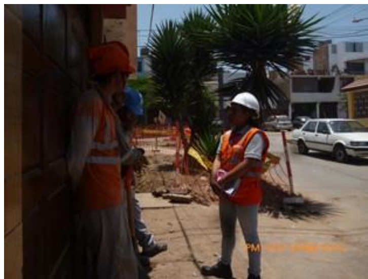
Instalación de cables subterráneos – mantenimiento de redes
