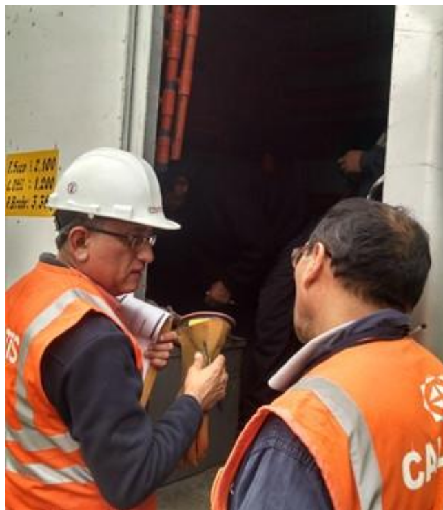
Cuadrilla del servicio de emergencia de media tensión
