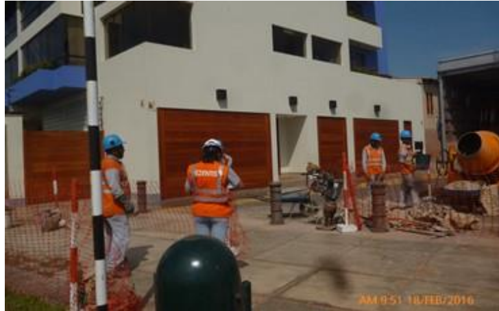
Reparación de veredas – alumbrado público
