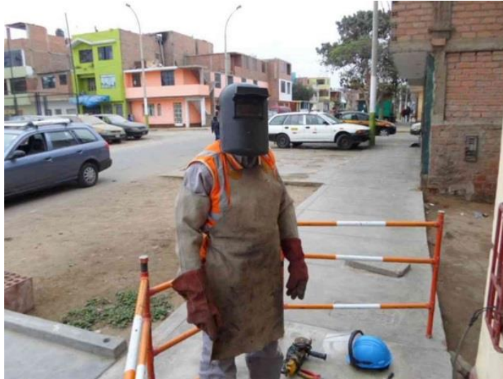
Figura N° 13: Trabajo de corte y reconexiones – actividad soldadura de tapa de suministro
