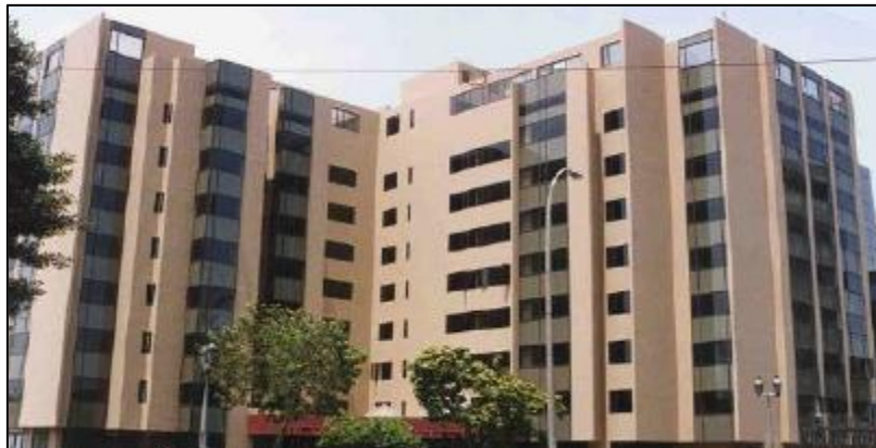
Fig. 9 Muros estructurales y pórticos.
