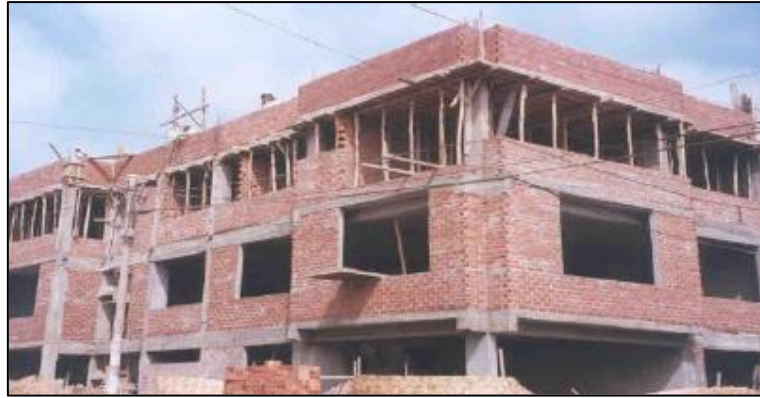
Fig. 8 Muros de albañilería.
