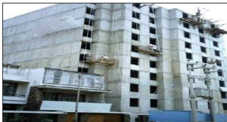
Fig. 7 Concreto armado – Sistema Aperticado.
