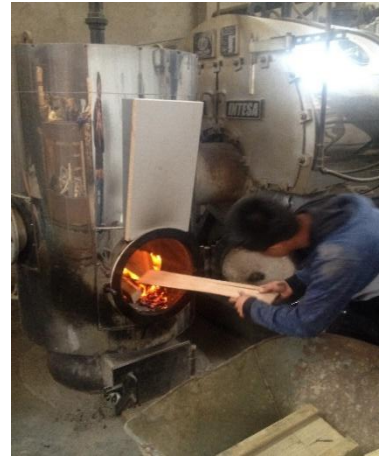
Alimentación del caldero piro-tubular
