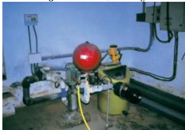
Figura 18: Cabezal de riego
