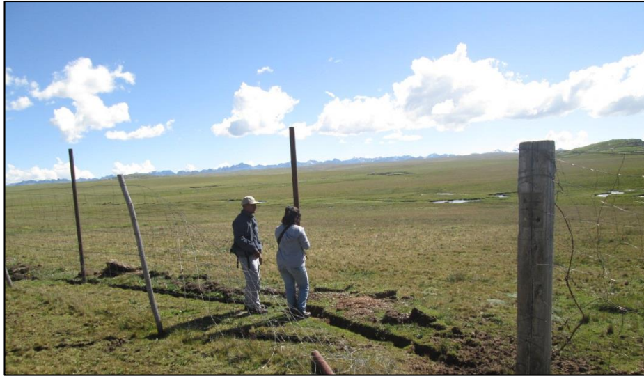
Figura 9: Cercado metálico deteriorado presuntamente por vicuñas.
