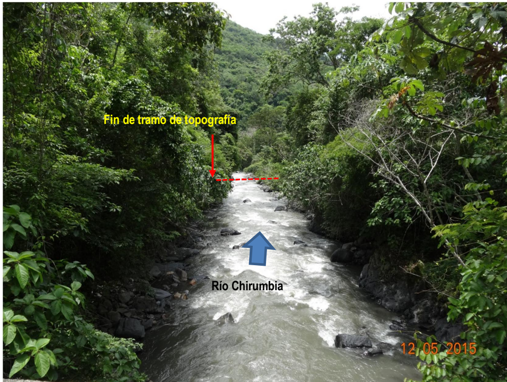
Figura 28 ó Vista hacia aguas abajo, desde puente Concepción
