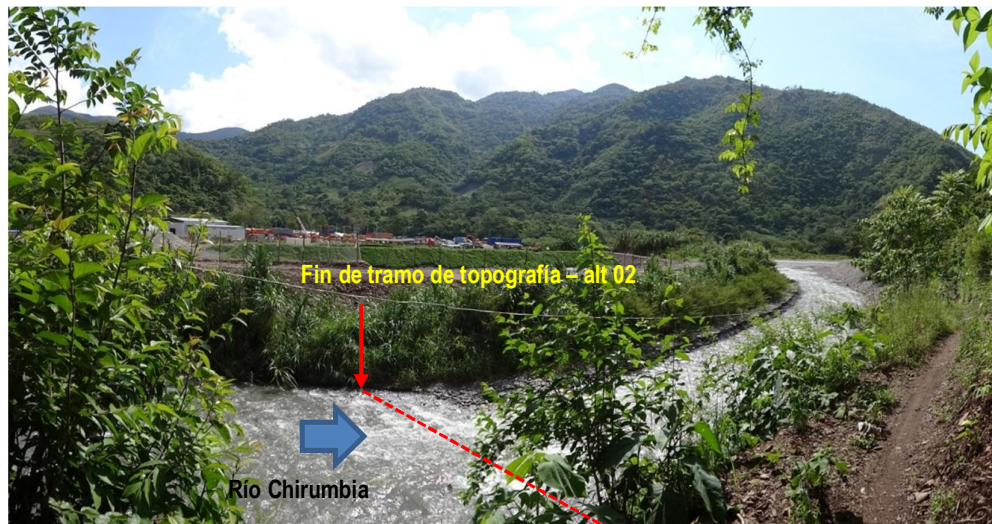
Figura 32 ó Vista del tramo para topografía de Regla AL-136, desde margen derecha
