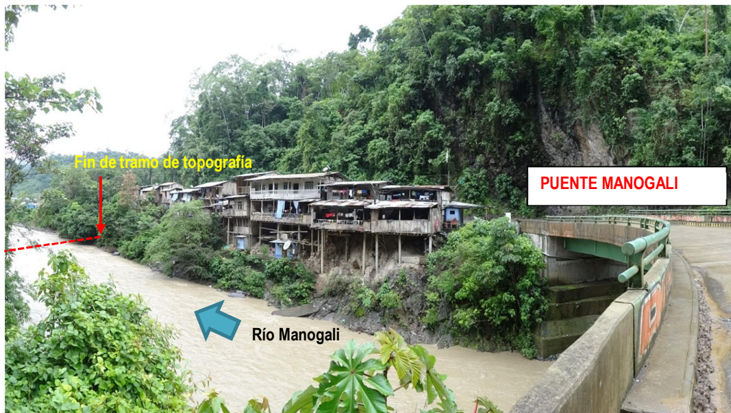
Figura 44 ó Vista hacia aguas abajo, tomada desde el puente Manogali
