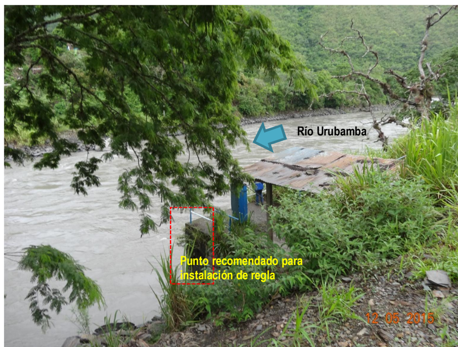
Figura 52 ó Estructura de soporte para ubicar la regla limnimétrica RQ-CA06
