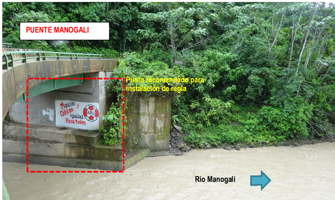
Figura 45 ó Vista del estribo del Puente Manogali ubicado en la margen izquierda
