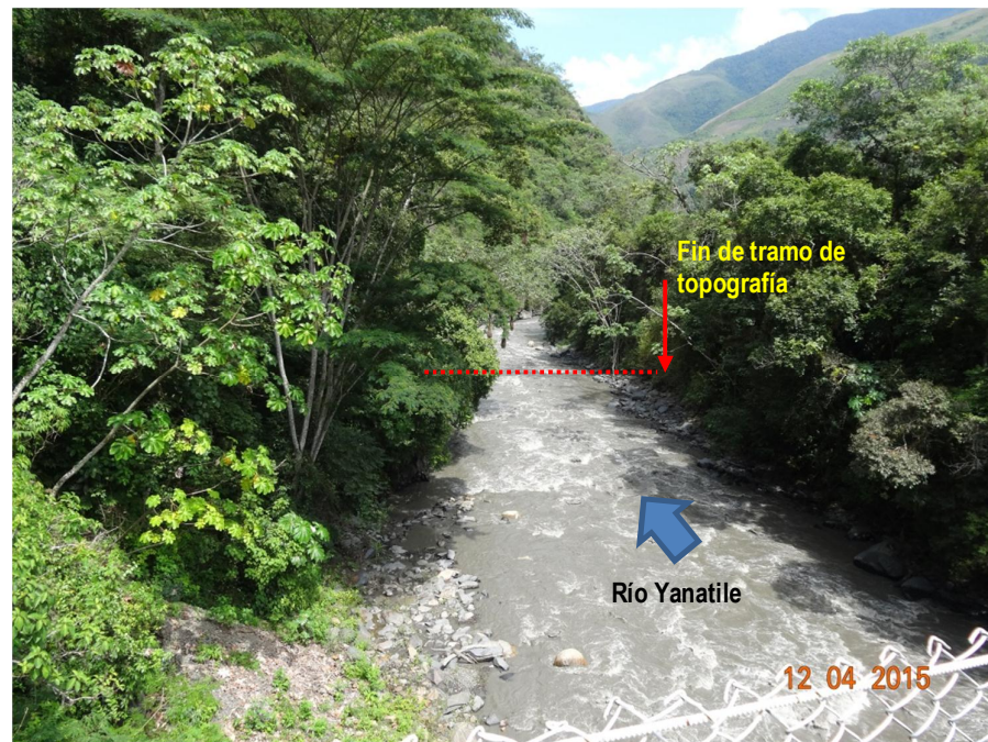
Figura 16 ó Vista hacia aguas abajo, desde puente Marampampa
