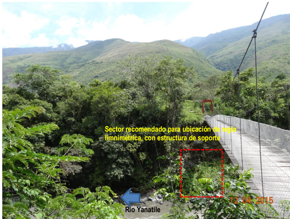
Figura 14 ó Vista de puente Marampampa desde margen izquierda
