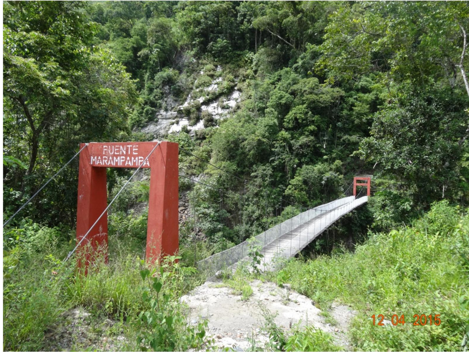
Figura 13 ó Vista de puente Marampampa desde margen derecha
