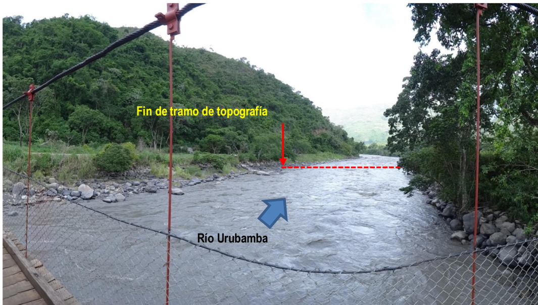
Figura 23 ó Vista hacia aguas abajo, desde puente peatonal
