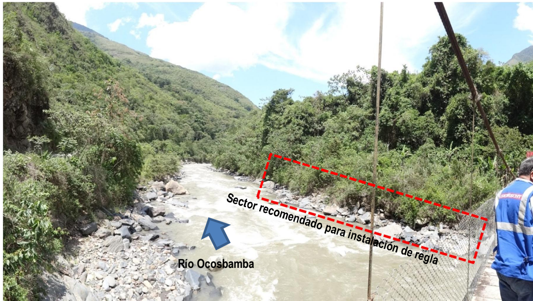
Figura 20 ó Vista del sector recomendado para instalación de Regla RL-07
