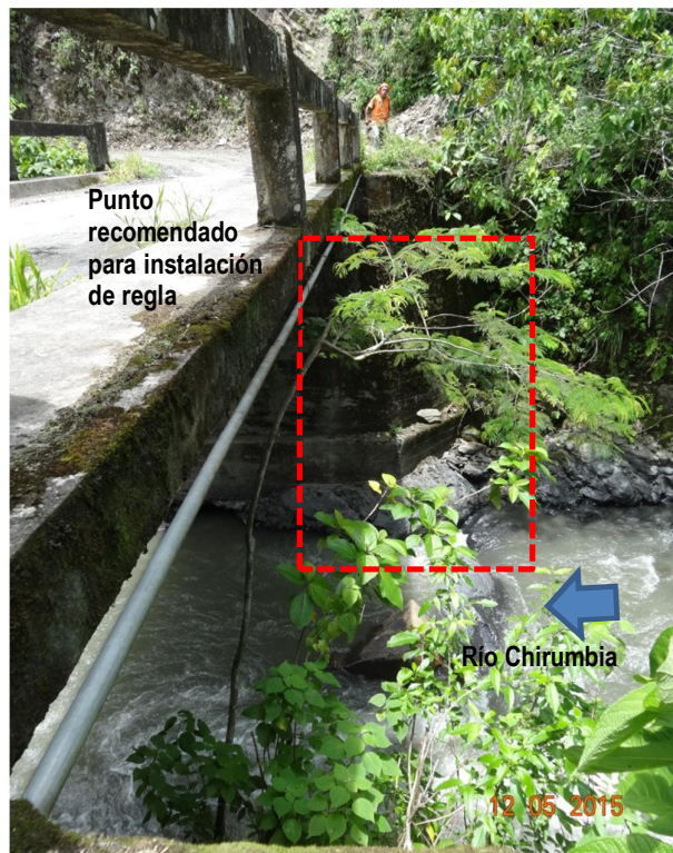
Figura 29 ó Vista del estribo derecho en puente Concepción
