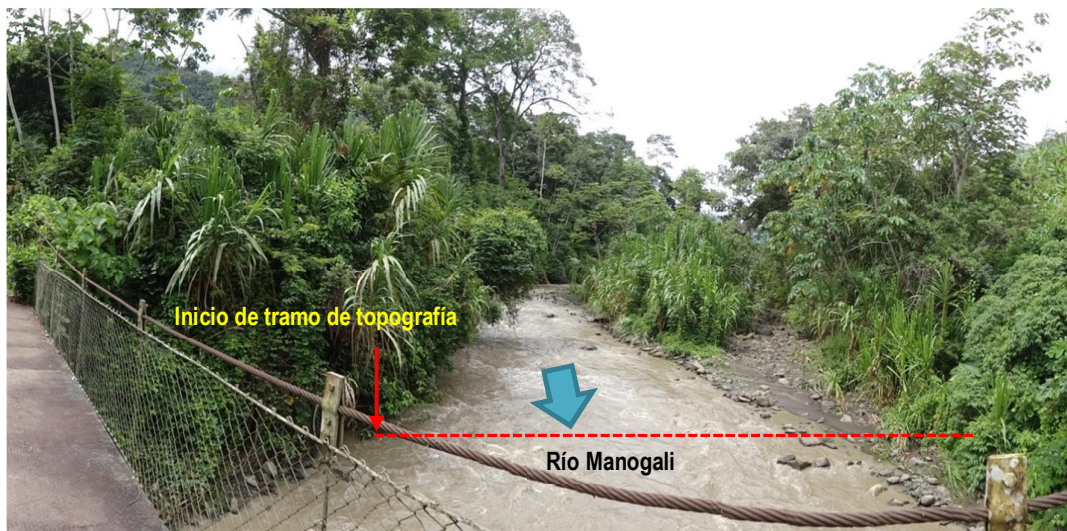
Figura 39 ó Vista hacia aguas arriba, tomada desde el puente peatonal
