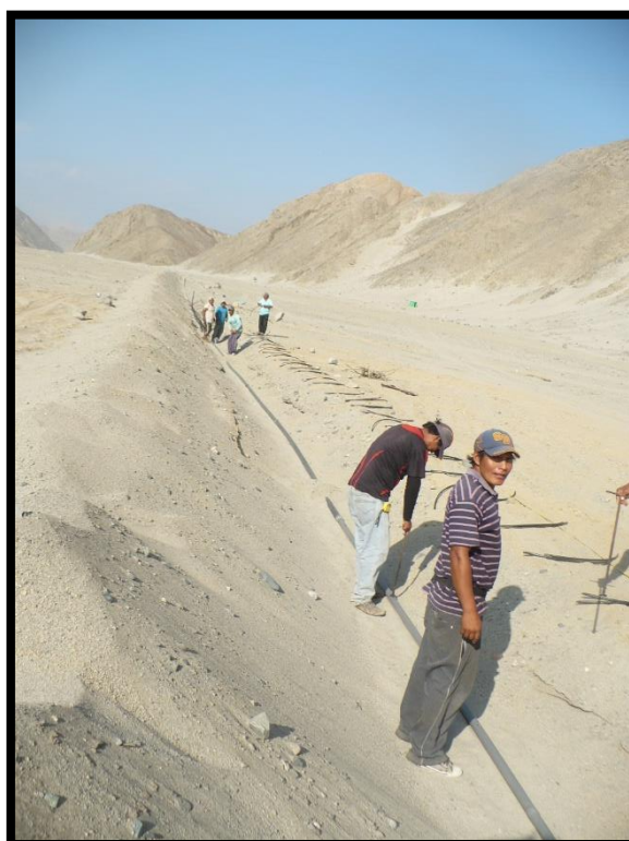
Foto N°2: Instalación de Sistema de Riego.
