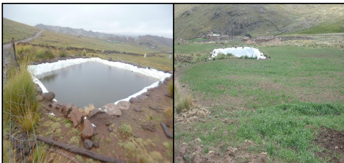
Foto 1: Vista panorámica de presencia de reservorios diseñados con geomembrana.
